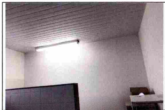
EMASSAMENTO E PINTURA EM PAREDE EM BLOCO DE GESSO
