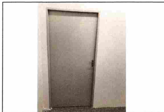
INSTALAÇÃO, PINTURA DE PORTA
