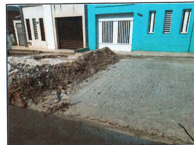
PAVIMENTAÇÃO DO TRECHO 03
