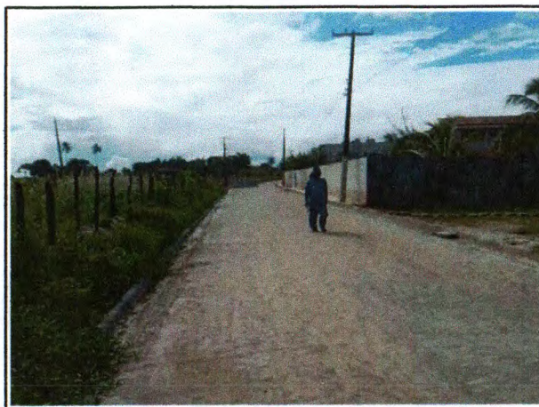
PAVIMENTAÇÃO DO TRECHO 02
