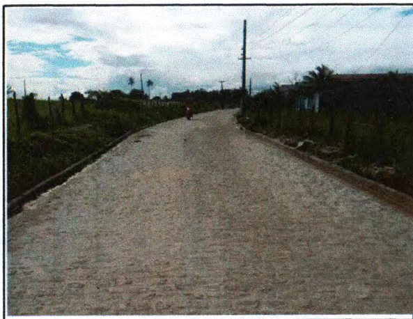
PAVIMENTAÇÃO DO TRECHO 02
