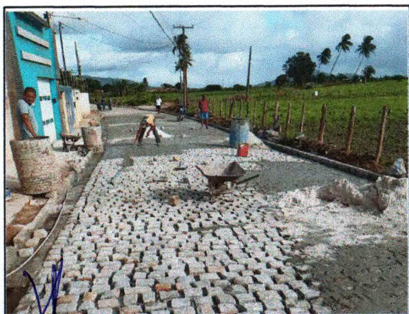
PAVIMENTAÇÃO DO TRECHO 02
