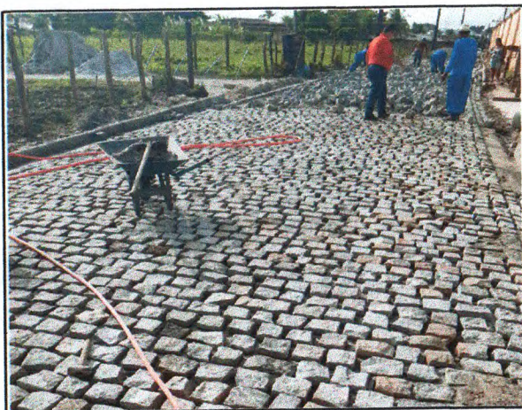
PAVIMENTAÇÃO DO TRECHO 03
