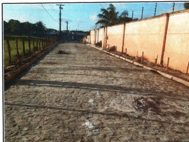
PAVIMENTAÇÃO DO TRECHO 03
