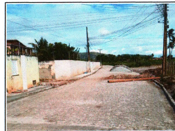
PAVIMENTAÇÃO DO TRECHO 02
