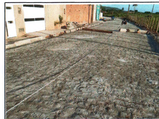
PAVIMENTAÇÃO DO TRECHO 03
