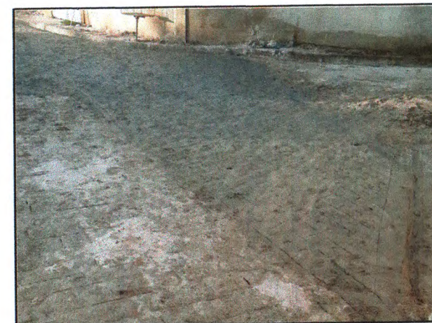
PAVIMENTAÇÃO DO TRECHO 03
