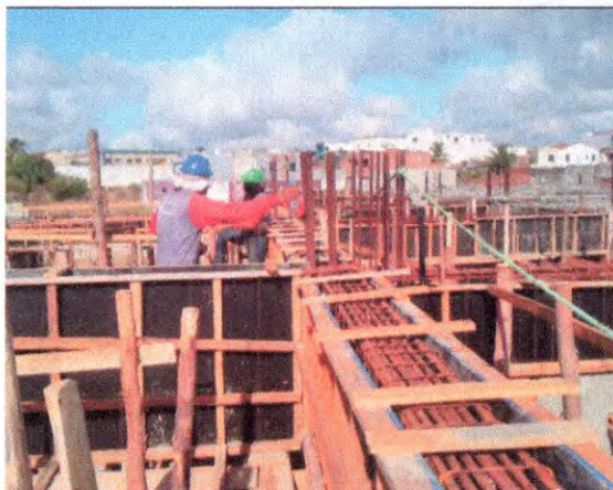
AÇO DAS VIGAS
