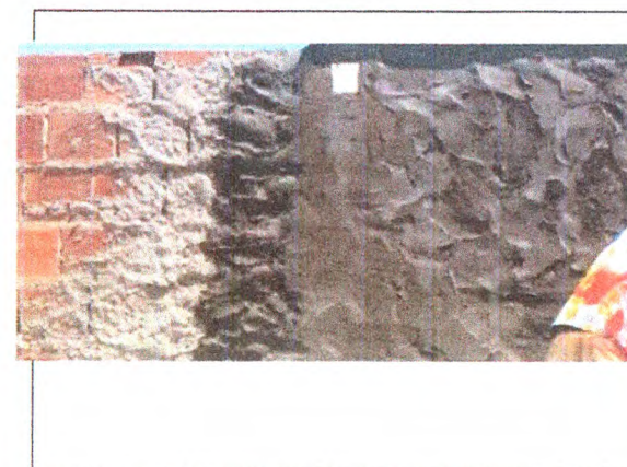
CHAPISCO E REBOCO FACHADA
