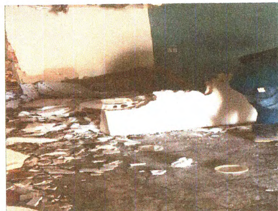
demolição de alvenaria de bloco de gesso
