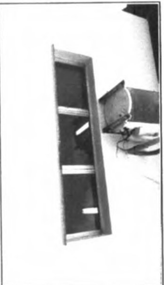
REVISÃO DAS ESQUADRIA DE ALUMÍNIO E INSTALAÇÃO DO VIDRO
