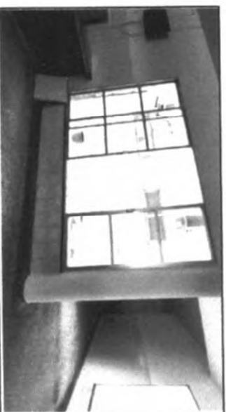
REVISÃO DAS ESQUADRIA DE ALUMÍNIO
