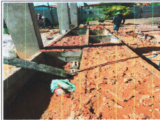
MONTAGEM DA ESTRUTURA DO GALPÃO
