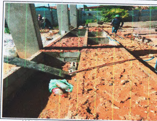
MONTAGEM DA ESTRUTURA DO GALPÃO
