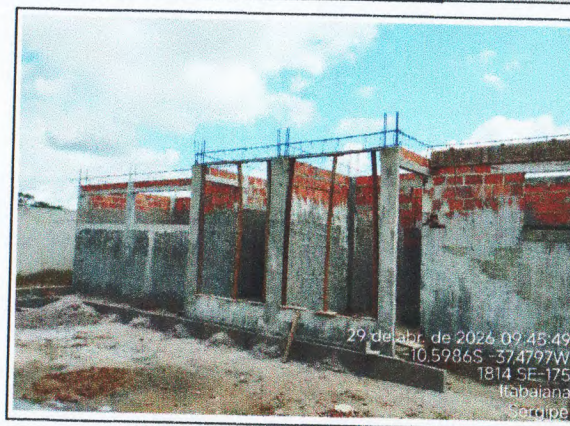
ALVENARIA DE BLOCO CERÂMICO
