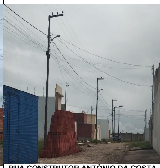
RUA CONSTRUTOR ANTÔNIO DA COSTA LIMA
