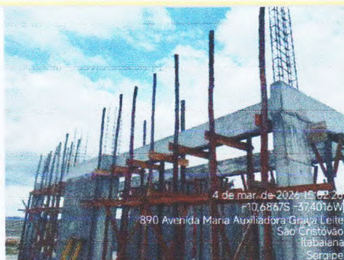
CONCRETAGEM DO ARGOLAMENTO
