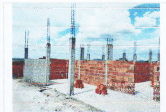
ALVENARIA DE BLOCO CERÂMICO
