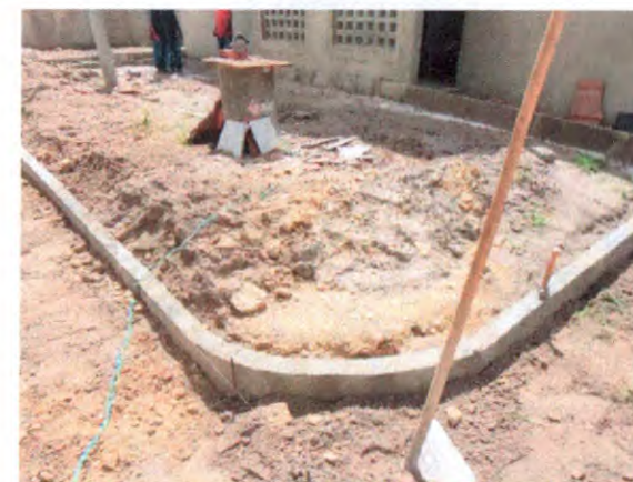
POSTES, CAIXA DE PASSAGEM, MEIO-FIO EM CONCRETO
