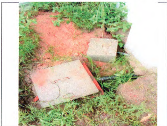
CAIXA DE PASSAGEM EM ALVENARIA; ELETRODUTO DE PVC
