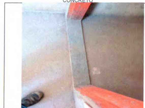
SOLEIRA EM GRANITO, REGULARIZAÇÃO DE BASE
