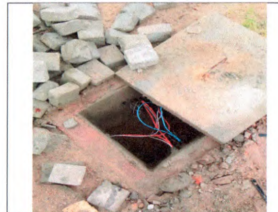
CAIXA DE PASSAGEM EM ALVENARIA; ELETRODUTO DE PVC; CABOS DE ENERGIA
