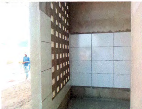
COBOGÓ, REVESTIMENTO CERÂMICO, REGULARIZAÇÃO DE BASE
