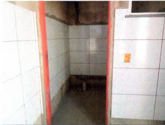
REVESTIMENTO, REGULARIZAÇÃO DE BASE, PONTO DE INTERRUPTOR, BASCULANTE EM ALUMÍNIO,
