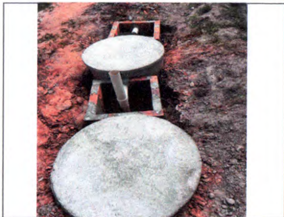
FOSSA SEPTICA E FILTRO ANAERÓBIO
