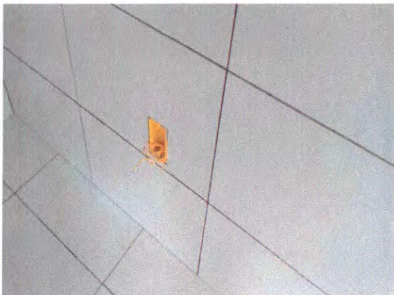
CAIXA DE PASSAGEM DE PVC; CABOS DE ENERGIA
