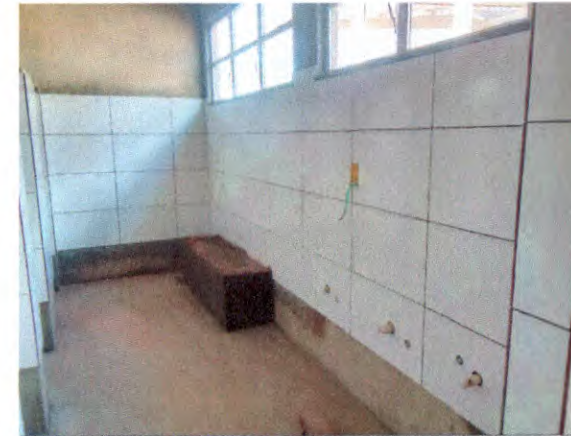
REVESTIMENTOS, PONTOS DE AGUA E REGISTROS, PONTO DE TOMADA, BASCULANTES, PEITORIL
