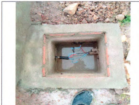
CAIXA DE PASSAGEM EM ALVENARIA; ELETRODUTO DE PVC; CABOS DE ENERGIA
