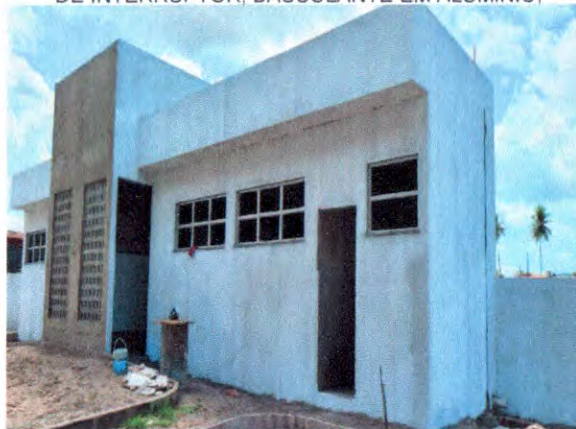
COBOGÓ, ESQUADRIAS, PEITORIS, PINTURA EXTERNA, MEIO-FIO EM CONCRETO
