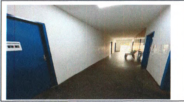
EXECUÇÃO DE PAREDES DE GESSO, EMASSAMENTO E PINTURAS DE PAREDES
