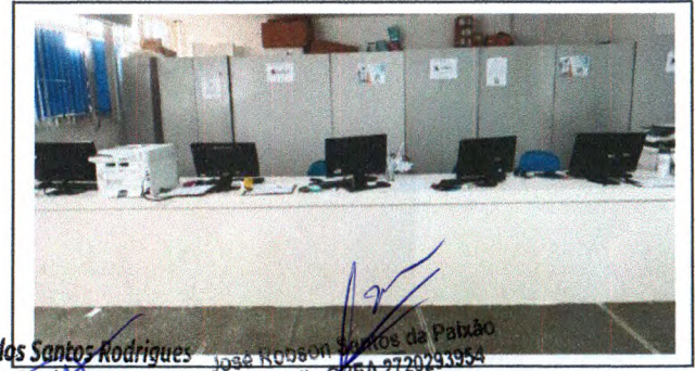
EXECUÇÃO DE BALÇÃO EM GESSO, EMASSAMENTO E PINTURA
