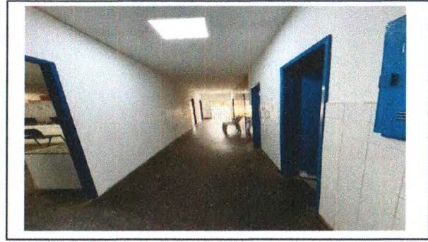
EXECUÇÃO DE PAREDES DE GESSO, EMASSAMENTO E PINTURAS DE PAREDES
