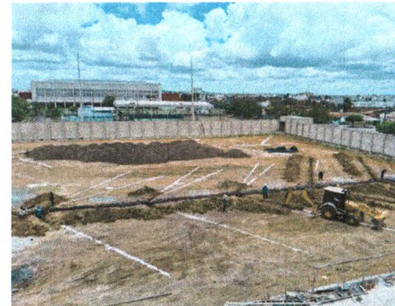
LOCAÇÃO DA REDE DE DRENAGEM;
