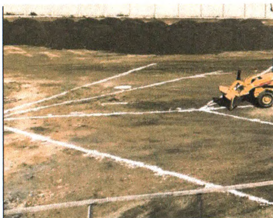
LOCAÇÃO DA REDE DE DRENAGEM;
