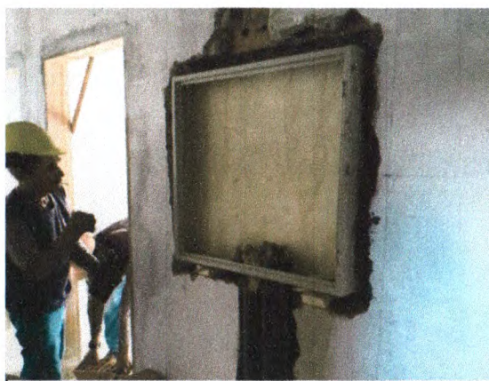
INSTALAÇÃO DAS CAIXAS DE PASSAGEM
