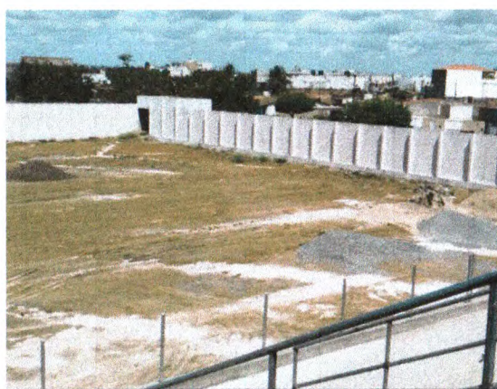
ESCAVAÇÃO MECANIZADA; PINTURA EXTERIOR;
