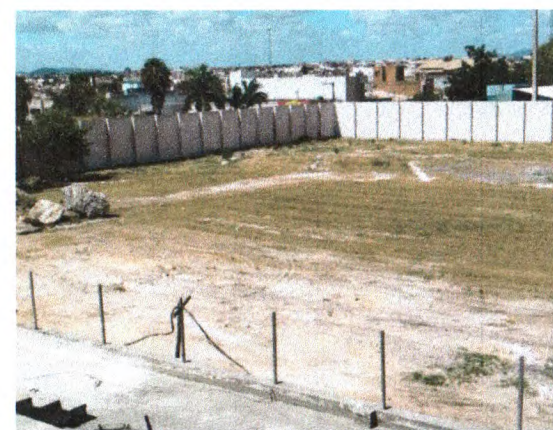
ESCAVAÇÃO MECANIZADA; PINTURA EXTERIOR;
