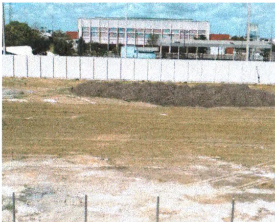
ESCAVAÇÃO MECANIZADA; PINTURA EXTERIOR;
