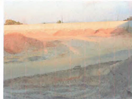
EXECUÇÃO DO ATERRO COM MATERIAL DE SUB-BASE
