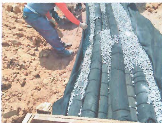
EXECUÇÃO DA DRENAGEM PLUVIAL
