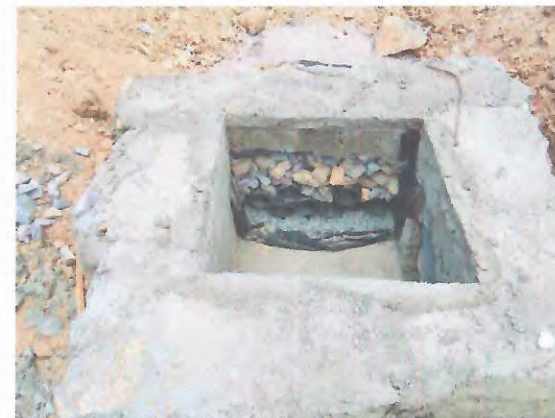
EXECUÇÃO DA DRENAGEM PLUVIAL; POÇO DE VISITA
