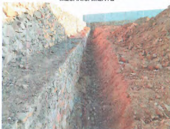
EXECUÇÃO DO ATERRO COM MATERIAL DE SUB-BASE; EXECUÇÃO DA DRENAGEM PLUVIAL
