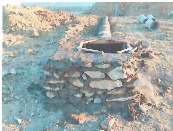
EXECUÇÃO DA DRENAGEM PLUVIAL; POÇO DE VISITA
