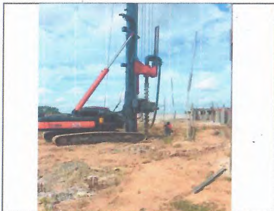
EXECUÇÃO DAS ESTACAS ESCAVADAS MECANICAMENTE
