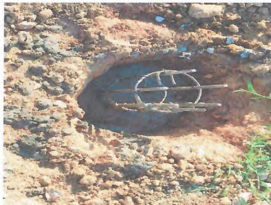
ESTACAS EM CONCRETO ARMADO
