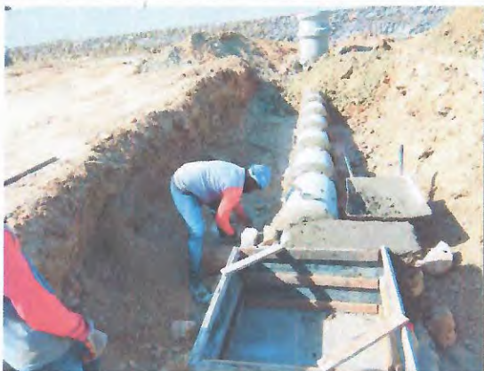
EXECUÇÃO DA DRENAGEM PLUVIAL; POÇO DE VISITA
