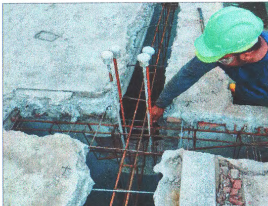
EXECUÇÃO DE PILARES E VIGAS EM CONCRETO ARMADO;
