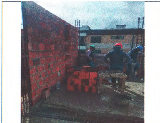
ALVENARIA DE BLOCO CERÂMICO; FERRAGEM DE VIGAS E PILARES
