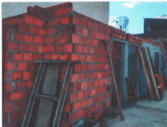
ALVENARIA DE BLOCO; CHAPISCO; REBOCO; VERGAS;
