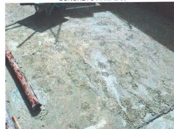
REGULARIZAÇÃO DE BASE;
