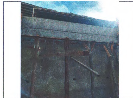
ALVENARIA DE BLOCO; CHAPISCO; CONCRETO ARMADO DE VIGAS
