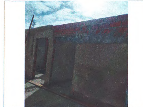
ALVENARIA DE BLOCO; CHAPISCO; REBOCO; VERGAS
