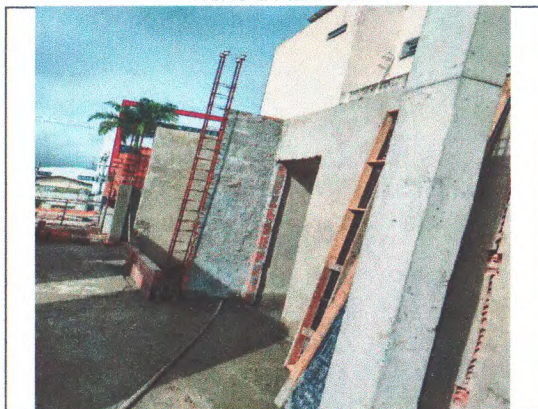
ALVENARIA DE BLOCO; CHAPISCO; REBOCO; VERGAS; CONCRETO E FERRAGEM DE PILARES
