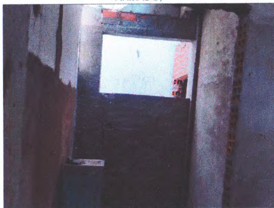
ALVENARIA DE BLOCO; CHAPISCO; REBOCO; VERGAS;
