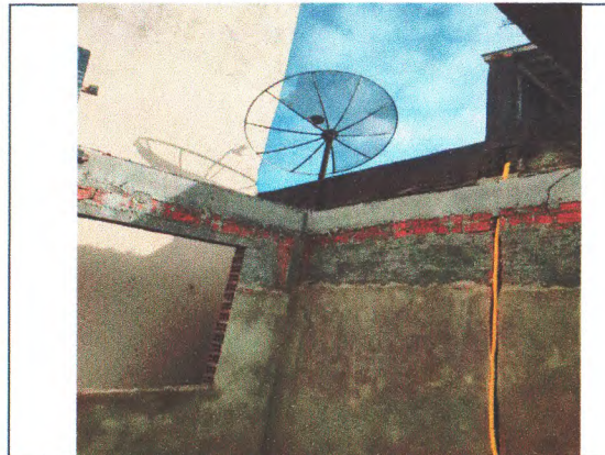
ALVENARIA DE BLOCO; CHAPISCO; REBOCO; VERGAS; CONCRETO ARMADO DE VIGAS
