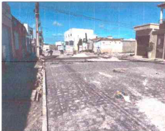
EXECUÇÃO DA PAVIMENTAÇÃO NA RUA PEDRO BARBOSA DE JESUS
