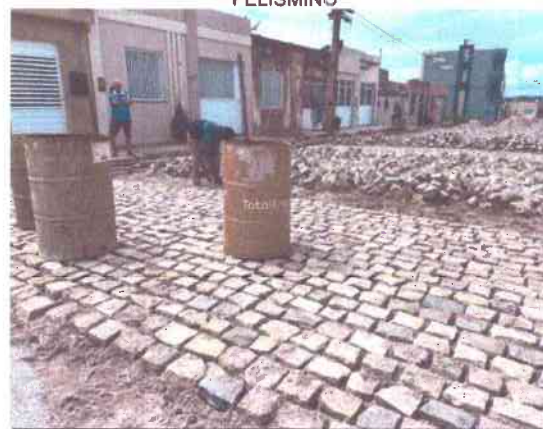
ASSENTAMENTO DE PARALELEPÍPEDO NA RUA PEDRO BARBOSA DE JESUS
