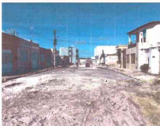
COLCHÃO DE AREIA NA RUA PEDRO BARBOSA DE JESUS
