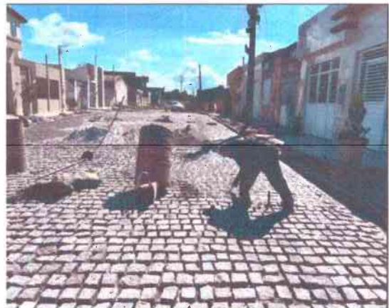
CONCRETAGEM DO PARALELEPÍPEDO NA RUA PEDRO BARBOSA DE JESUS
