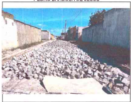
COLCHÃO DE AREIA, PARALELEPÍPEDO E MEIO-FIO NA RUA ALLAN KARDEC
