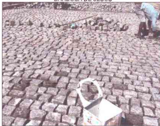
EXECUÇÃO DA PAVIMENTAÇÃO NA RUA ALLAN KARDEC
