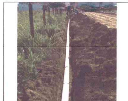
TUBULAÇÃO PARA ESGOTO NA RUA PADRE FELISMINO
