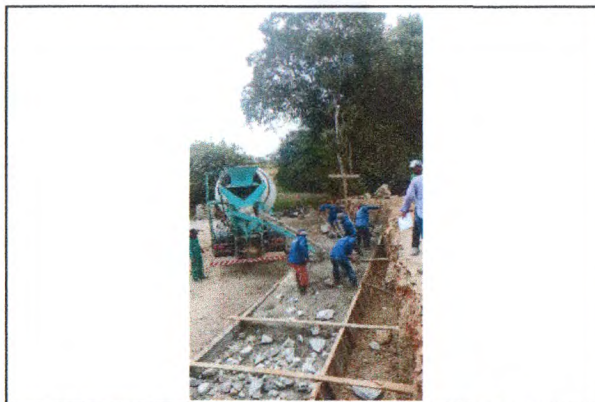
CONCRETO CICLÓPICO - BASE DA PONTE
