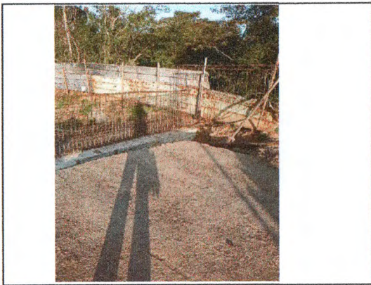
MONTAGEM DE AÇO DAS ALAS
