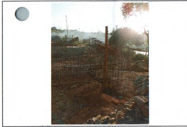
MONTAGEM DE AÇO DAS ALAS
