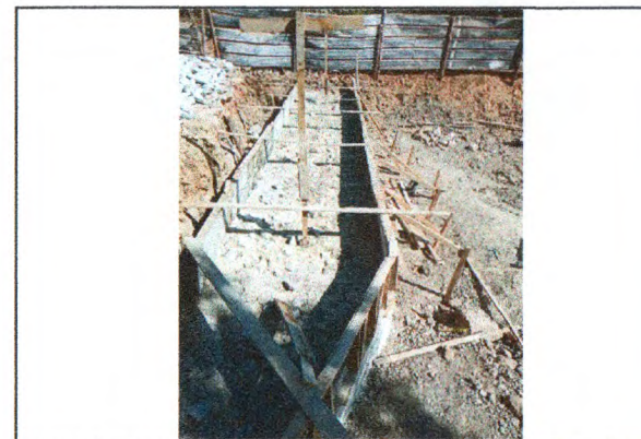
CONCRETO CICLÓPICO - BASE DA PONTE
