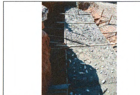
CONCRETO CICLÓPICO - BASE DA PONTE
