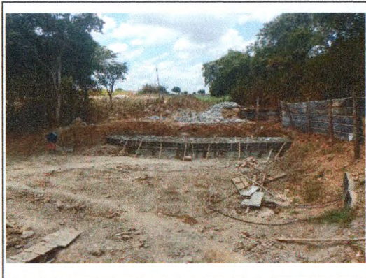
CONCRETO CICLÓPICO - BASE DA PONTE
