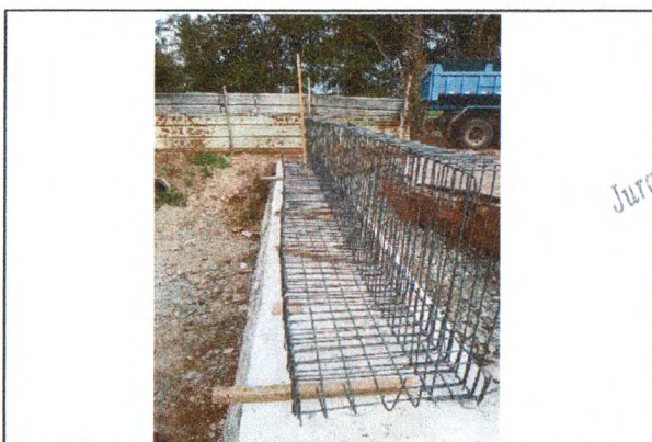
MONTAGEM DE AÇO DO BERÇO E CORTINA
