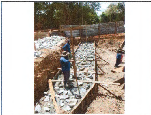
CONCRETO CICLÓPICO - BASE DA PONTE
