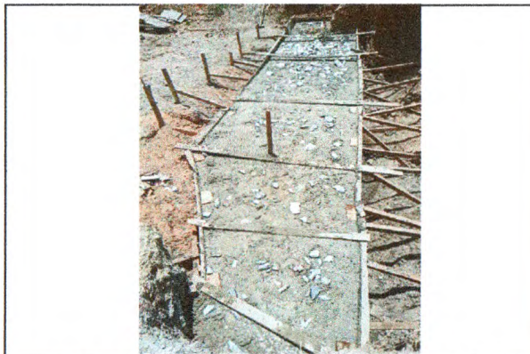
CONCRETO CICLÓPICO - BASE DA PONTE
