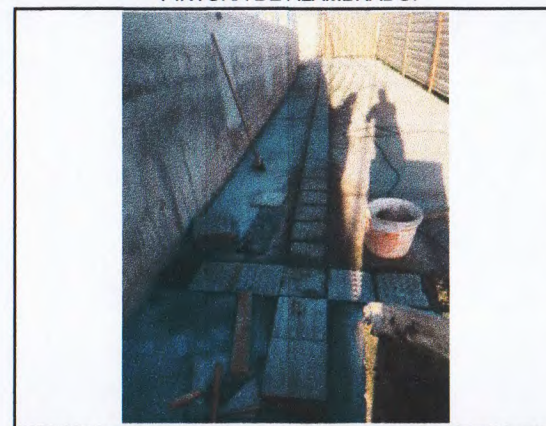
ASSENTAMENTO DE PISO TÁTIL; PISO EM CONCRETO;
