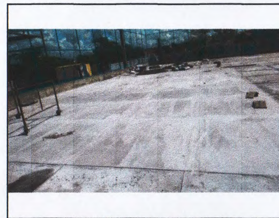
EXECUÇÃO DE ALTA RESISTENCIA.
