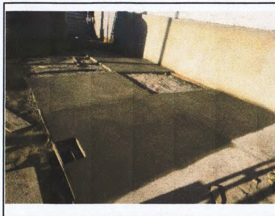
PISO EM CONCRETO.
