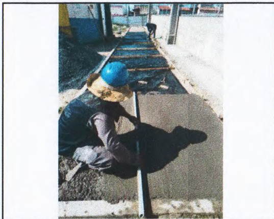
PISO EM CONCRETO.
