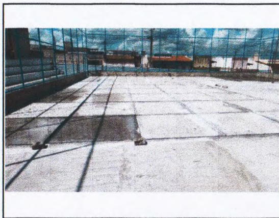
EXECUÇÃO DE ALTA RESISTENCIA.
