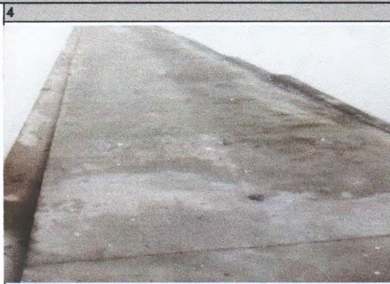
Imagem 4 - Junta de dilatação
