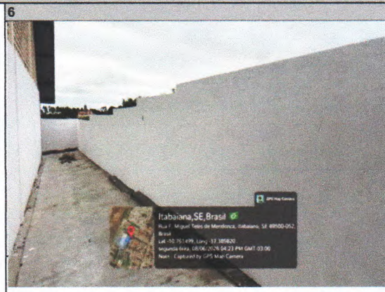
Imagem 6 - Aplicação de massa acrílica nos muros e paredes externas
