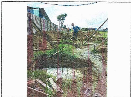
ESCAVAÇÃO; FERRAGEM E CONCRETO DAS SAPATAS
