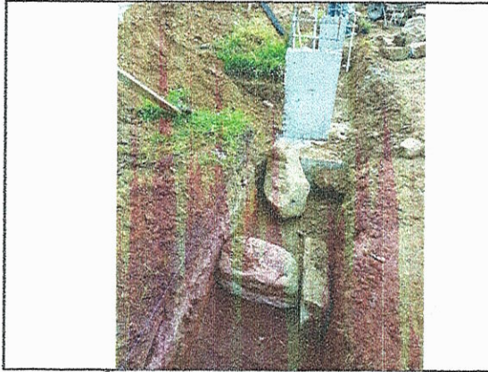
ESCAVAÇÃO MANUAL; SAPATAS E ARRANQUES DOS PILARES; ALVENARIA DE PEDRA ARGAMASSADA
