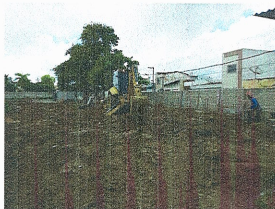
ESCAVAÇÃO E REGULARIZAÇÃO DO TERRENO
