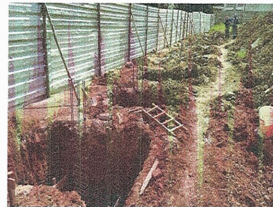
ESCAVAÇÃO; FERRAGEM DAS SAPATAS
