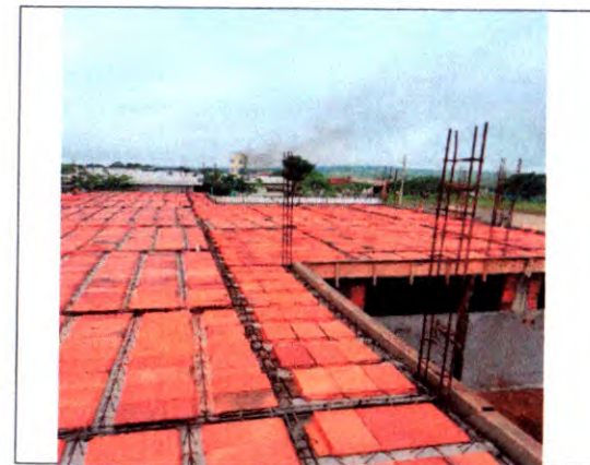
LAJE PRÉ MOLDADA
