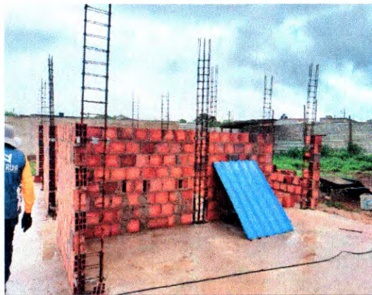
ELEVAÇÃO DE ALVENARIA E PILARES
