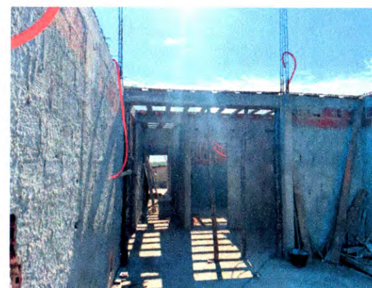
VIGA SUPERIOR E CHAPISCO
