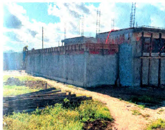
VIGA SUPERIOR E CHAPISCO
