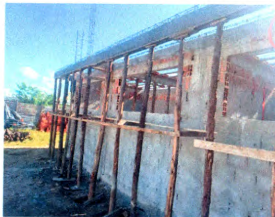
VIGA SUPERIOR E CHAPISCO
