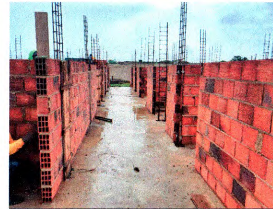
ELEVAÇÃO DE ALVENARIA E PILARES
