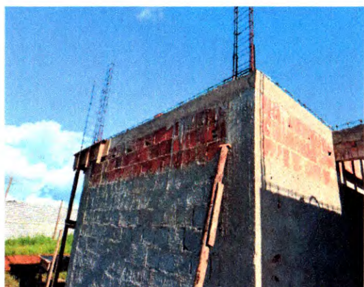
VIGA SUPERIOR E CHAPISCO
