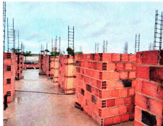
ELEVAÇÃO DE ALVENARIA E PILARES
