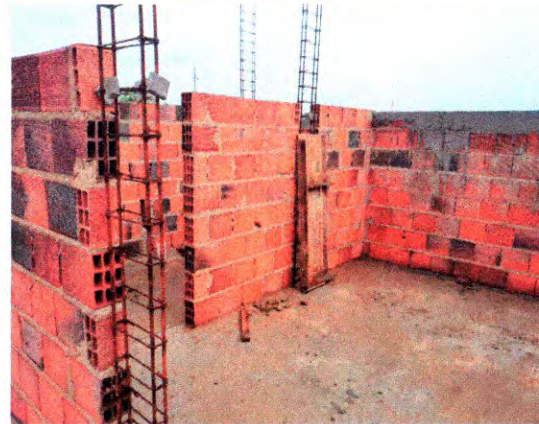
ELEVAÇÃO DE ALVENARIA, VERGAS E PILARES
