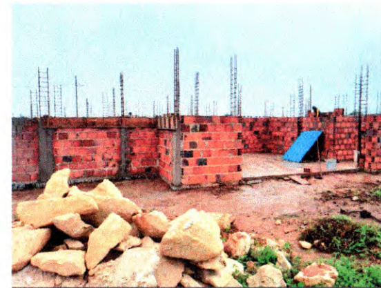
ELEVAÇÃO DE ALVENARIA E PILARES
