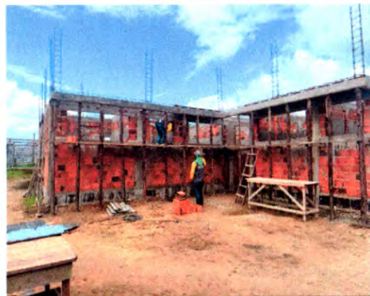
VIGA SUPERIOR E ELEVÇÃO DE ALVENARIA
