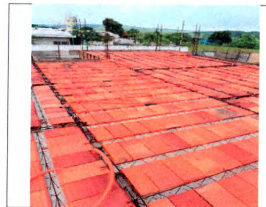
LAJE PRÉ MOLDADA
