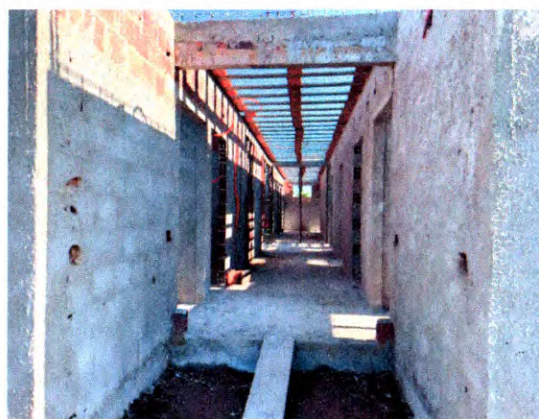
VIGA SUPERIOR E CHAPISCO
