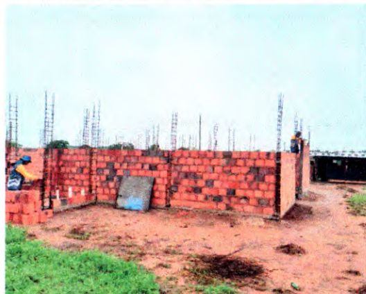
ELEVAÇÃO DE ALVENARIA E PILARES
