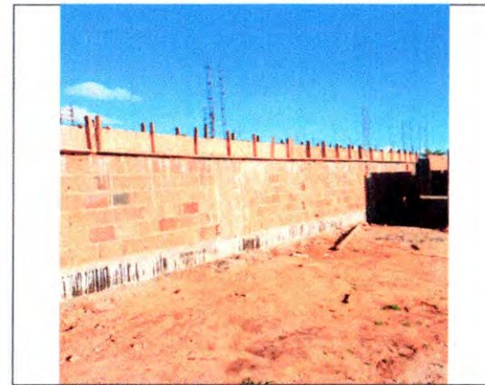
ELEVAÇÃO DE ALVENARIA, VERGAS E PILARES
