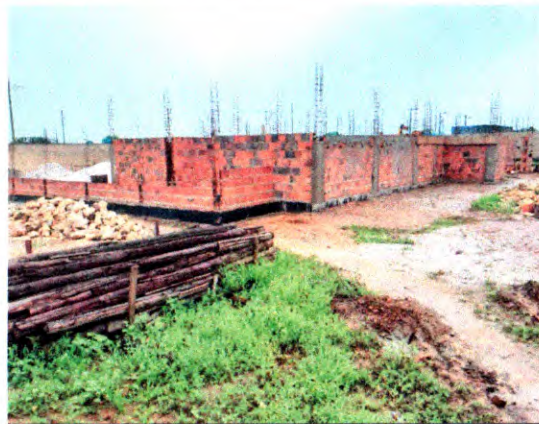
ELEVAÇÃO DE ALVENARIA E PILARES
