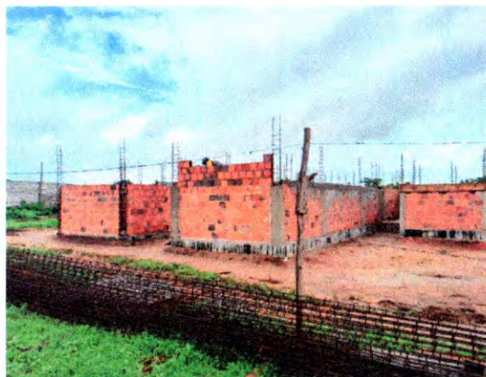
ELEVAÇÃO DE ALVENARIA E PILARES
