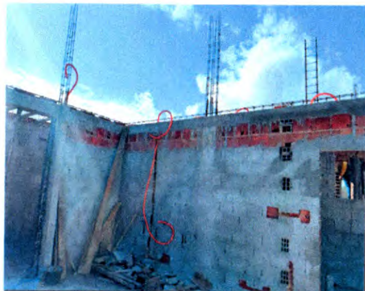
VIGA SUPERIOR E CHAPISCO
