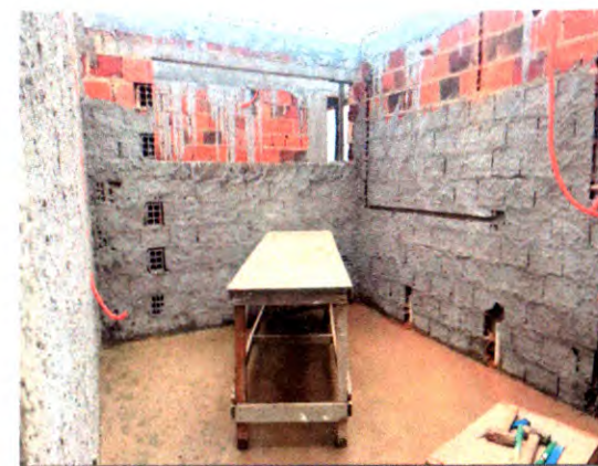
VIGA SUPERIOR E CHAPISCO
