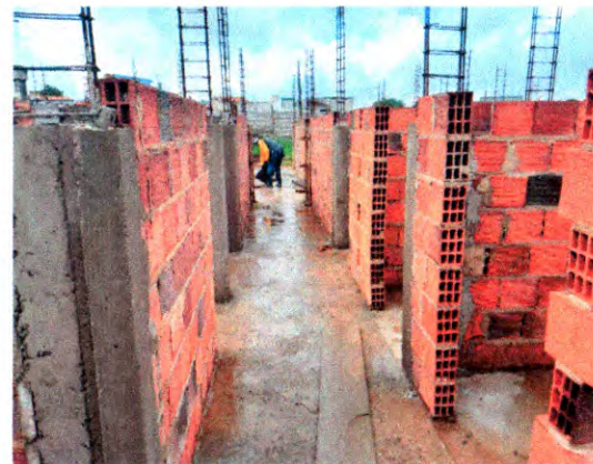
ELEVAÇÃO DE ALVENARIA E PILARES
