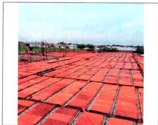
LAJE PRÉ MOLDADA
