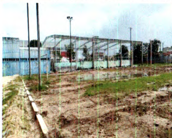
LIMPEZA MANUAL DE TERRENO
