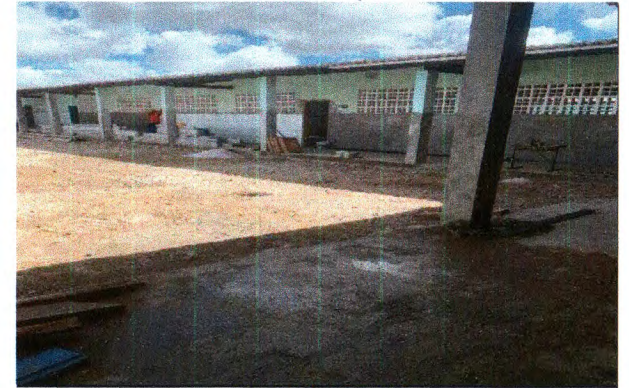
DEMOLIÇÃO DE PISO
