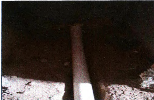
PONTO DE ESGOTO
