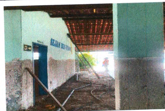
DEMOLIÇÃO DE PISO CIMENTADO
