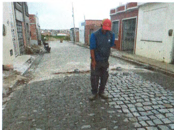
PAVIMENTAÇÃO NA TRV. XISTO ALVES DOS SANTOS
