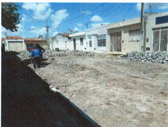
COLCHÃO DE AREIA, MEIO FIO E PARALELEPIPEDO NA RUA ANA SOUZA DE JESUS
