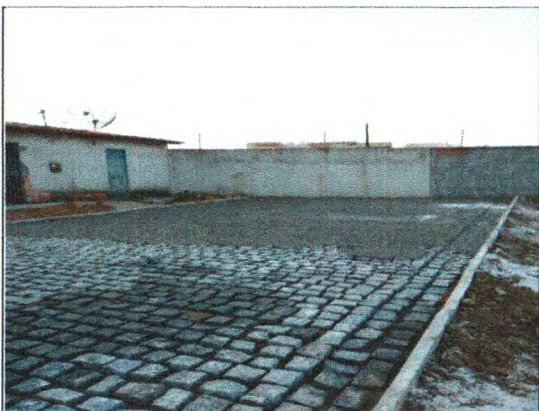
PAVIMENTAÇÃO NA RUA B (SEM NOME)
