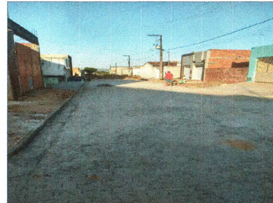
PAVIMENTAÇÃO NA RUA JOSIVAL DOS SANTOS
