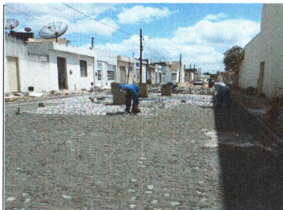
PAVIMENTAÇÃO NA RUA ANA SOUZA DE JESUS
