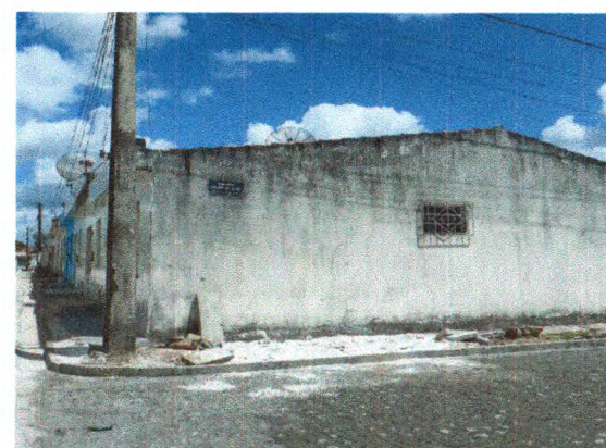
PAVIMENTAÇÃO NA RUA ANA SOUZA DE JESUS
