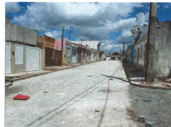
PAVIMENTAÇÃO NA TRV. XISTO ALVES DOS SANTOS
