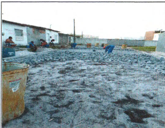
COLCHÃO DE AREIA, MEIO FIO E PARALELEPIPEDO NA RUA B (SEM NOME)
