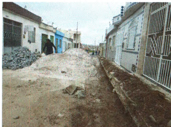
COLCHÃO DE AREIA NA TRV XISTO ALVES DOS SANTOS
