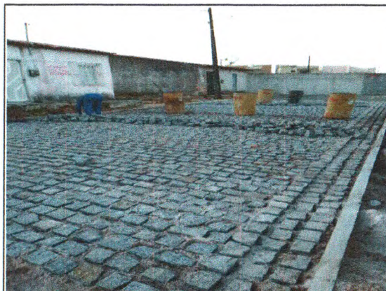
COLCHÃO DE AREIA, MEIO FIO E PARALELEPIPEDO NA RUA B (SEM NOME)
