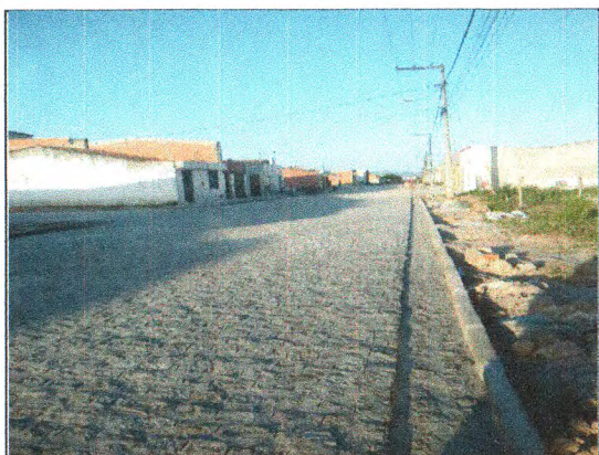
PAVIMENTAÇÃO NA RUA JOSIVAL DOS SANTOS
