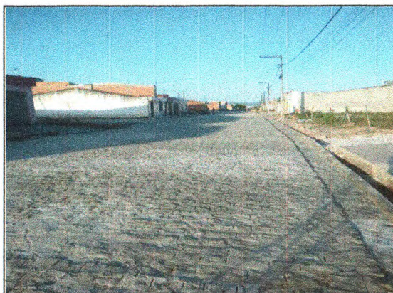
PAVIMENTAÇÃO NA RUA JOSIVAL DOS SANTOS
