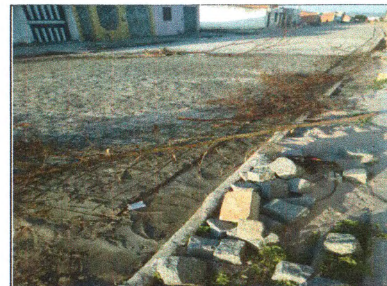
PAVIMENTAÇÃO NA RUA JOSIVAL DOS SANTOS
