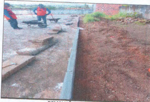
DEMOLIÇÃO DE MEIO FIO
