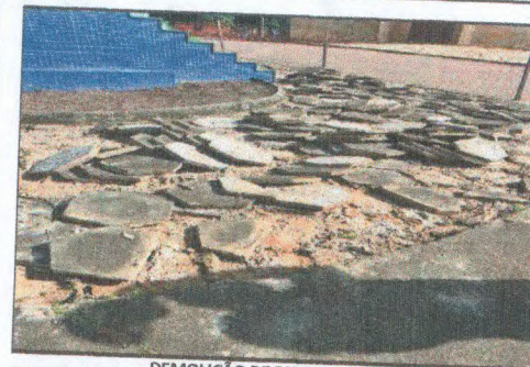
DEMOLIÇÃO DE PISO EXAGORAL
