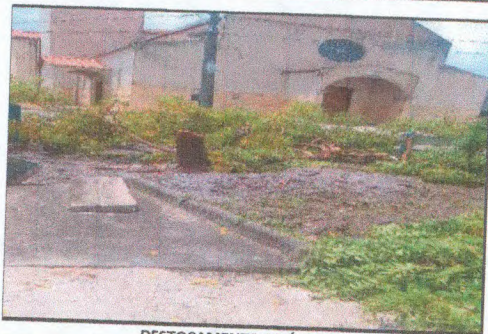
DESTOCAMENTO DE ÁRVORE
