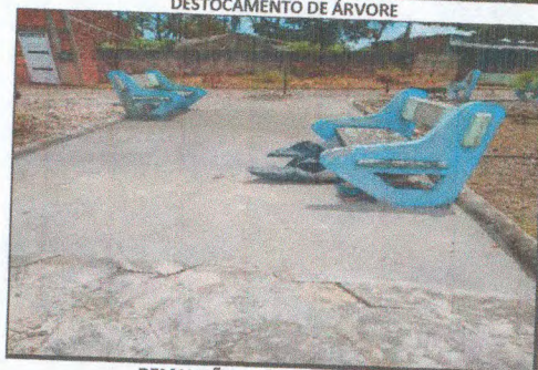
DEMOLIÇÃO DE PISO CIMENTADO
