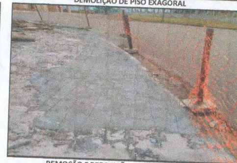
REMOÇÃO E REPOSIÇÃO DE PARALELEPIPEDO
