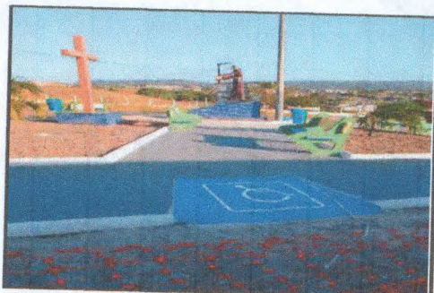
DEMARCAÇÃO DE PAVIMENTO
