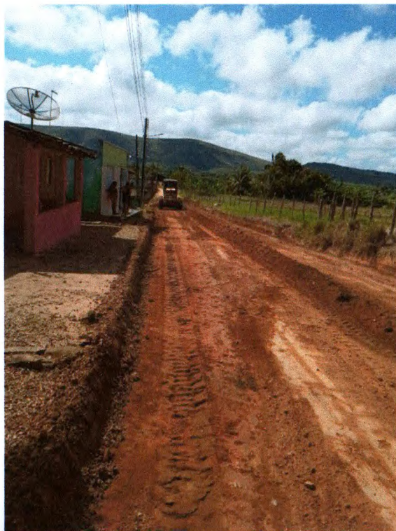
Foto 01: Regularização e compactação de subleito de solo.
