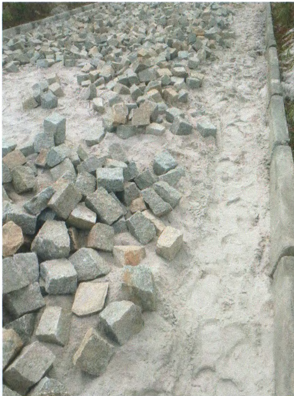
Foto 04: Colchão de areia.
