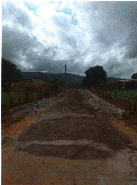
Foto 02: Locação de serviços de pavimentação.
