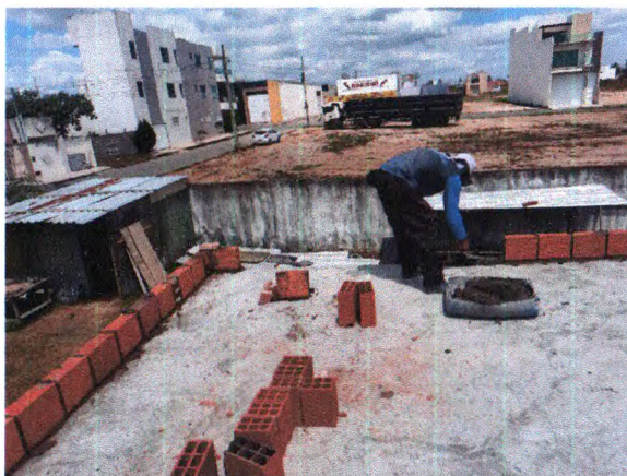
LAJE PRÉ-FABRICADA TRELIÇADA
