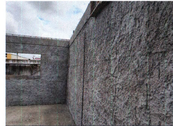
ALVENARIA DE BLOCO CERÂMICO; PILARES, VERGA E CONTRAVERGA EM CONCRETO ARMADO; CHAPISCO; REBOCO
