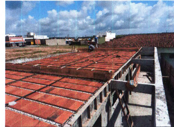
LAJE PRÉ-FABRICADA TRELIÇADA
