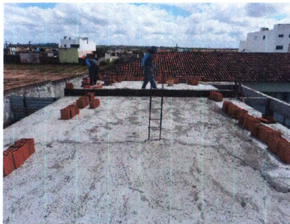
LAJE PRÉ-FABRICADA TRELIÇADA
