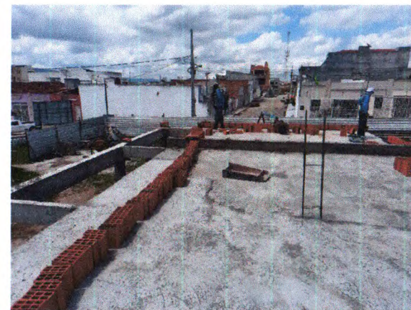
LAJE PRÉ-FABRICADA TRELIÇADA
