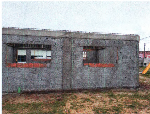
ALVENARIA DE BLOCO CERÂMICO; PILARES, VERGA E CONTRAVERGA EM CONCRETO ARMADO; CHAPISCO
