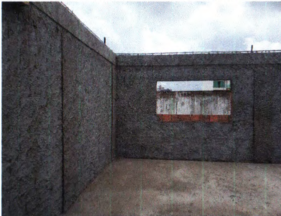
ALVENARIA DE BLOCO CERÂMICO; PILARES, VERGA E CONTRAVERGA EM CONCRETO ARMADO; CHAPISCO; REBOCO
