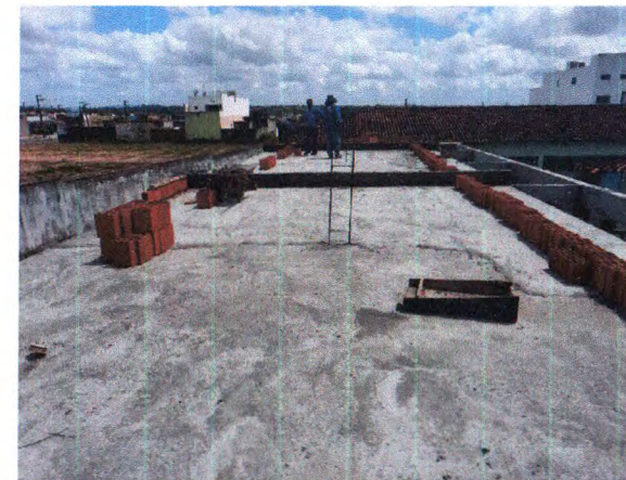
LAJE PRÉ-FABRICADA TRELIÇADA
