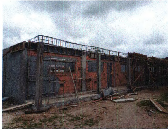
ALVENARIA DE BLOCO CERÂMICO; PILARES, VERGA E CONTRAVERGA EM CONCRETO ARMADO
