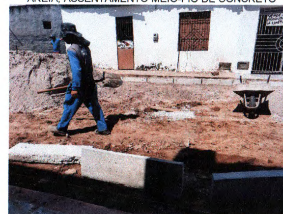
RUA JOSÉ LIMA - REGULARIZAÇÃO; COLCHÃO DE AREIA; ASSENTAMENTO MEIO-FIO DE CONCRETO
