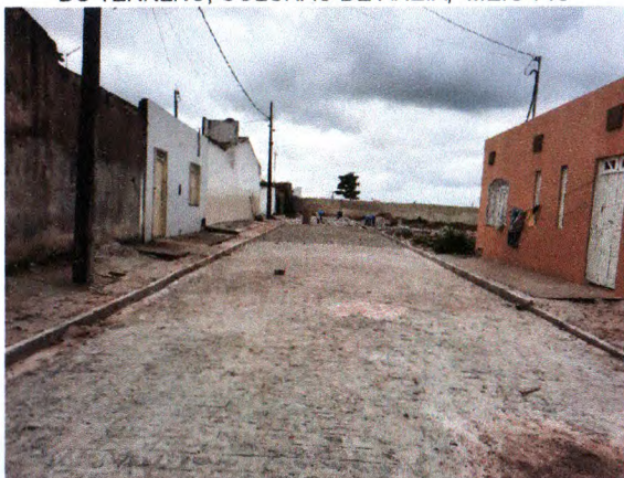
RUA JOSÉ VINCENTE DE ALMEIDA - ASSENTAMENTO MEIO-FIO E PARALELEPÍEDO; DRENAGEM SUPERFICIAL
