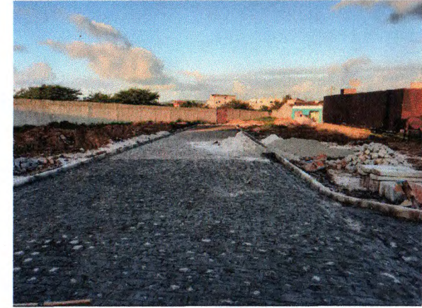
RUA PROJETADA "A" - ASSENTAMENTO MEIO-FIO E PARALELEPÍPEDO; DRENAGEM SUPERFICIAL
