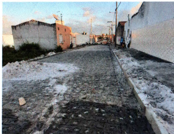
RUA JOSÉ VINCENTE DE ALMEIDA - REGULARIZAÇÃO DO TERRENO; COLCHÃO DE AREIA; MEIO-FIO
