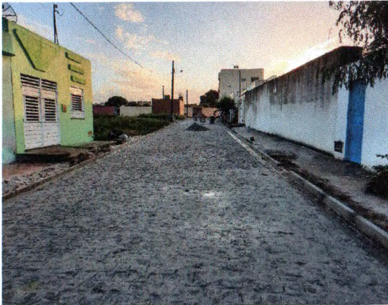
RUA PROJETADA "A" - ASSENTAMENTO MEIO-FIO E PARALELEPÍPEDO; DRENAGEM SUPERFICIAL
