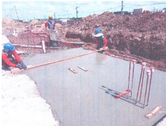
ADMINISTRAÇÃO - FERRAGEM, FORMA E CONCRETAGEM DA LAJE EM BALANÇO
