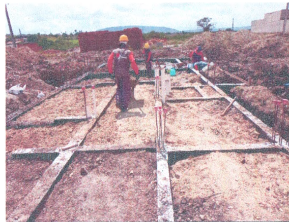
ADMINISTRAÇÃO - CIMENTAMENTO INFERIOR; IMPERMEABILIZAÇÃO; ATERRO COMPACTADO
