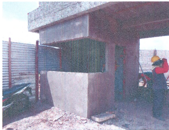
GUARITA - LAJE PRÉ-MOLDADA; CHAPISCO E REBOCO
