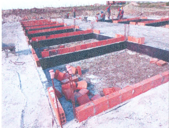
BAIAS COBERTAS - ESCAVAÇÃO; CINTAMENTO INFERIOR; IMPERMEABILIZAÇÃO; ATERRO COMPACTADO; ALVENARIA DE BLOCOS
