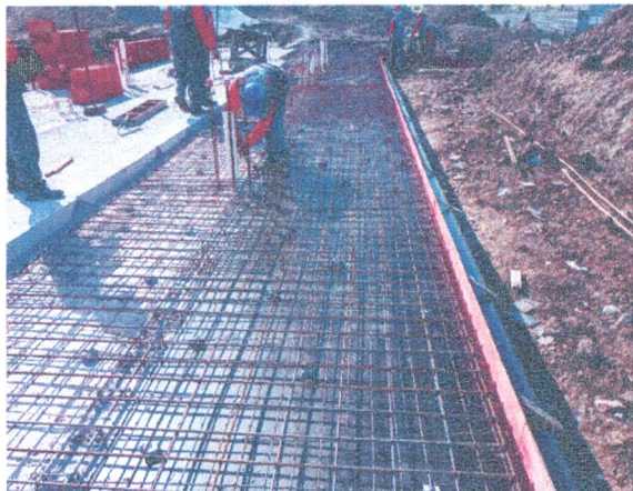
ADMINISTRAÇÃO - CAMADA IMPERMEABILIZADORA; FERRAGEM E FORMA DA LAJE EM BALANÇO
