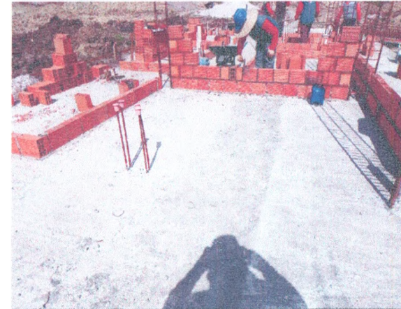
ADMINISTRAÇÃO - CAMADA IMPERMEABILIZADORA; FERRAGEM; ALVENARIA DE BLOCO
