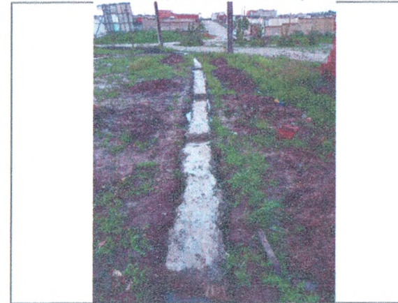
FECHAMENTO EXTERNO - ESCAVAÇÃO; ALVENARIA DE PEDRA ARGAMASSADA
