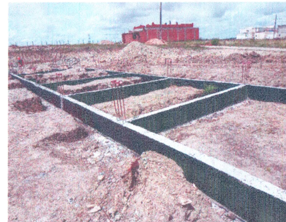
BAIAS COBERTAS - ESCAVAÇÃO; CINTAMENTO INFERIOR; IMPERMEABILIZAÇÃO
