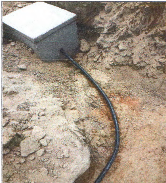
Caixa de passagem de alvenaria da Av. Engenheiro Carlos Reis
