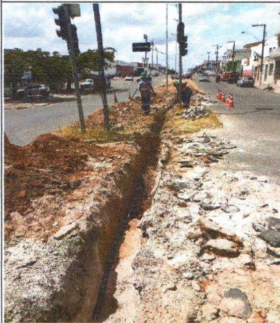
Tubulação da Av. Manoel Francisco Teles
