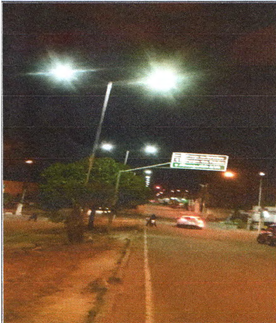
Postes com luminárias da Av. Manoel Francisco Teles
