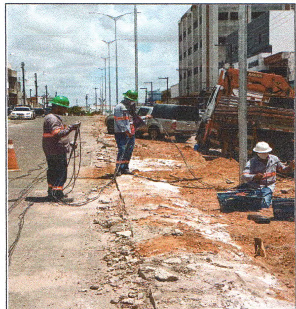
Enfição de alimentador para atender as luminárias na Av. Engenheiro Carlos Reis
