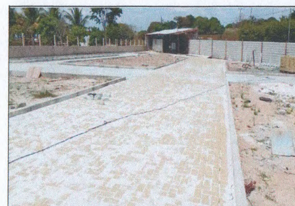
PAVIMENTAÇÃO EM INTERTRAVADO
