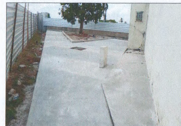
PISO EM CONCRETO
