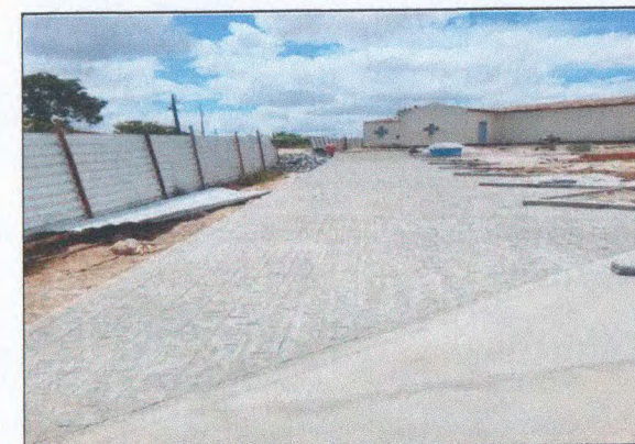
PAVIMENTAÇÃO EM PARALELEPIPEDO
