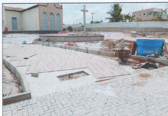
EXECUÇÃO DO PISO CERÂMICO
