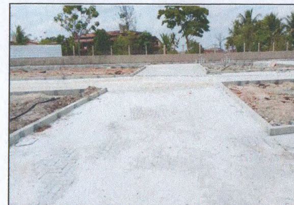
PAVIMENTAÇÃO EM INTERTRAVADO
