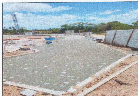
PAVIMENTAÇÃO EM PARALELEPIPEDO
