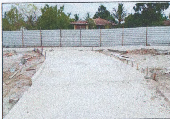
PISO EM CONCRETO
