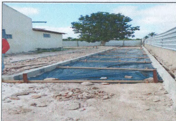
MEIO-FIO E LONA PLÁSTICA
