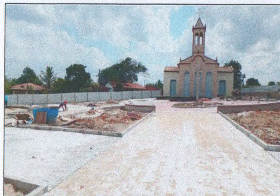
PAVIMENTAÇÃO EM INTERTRAVADO
