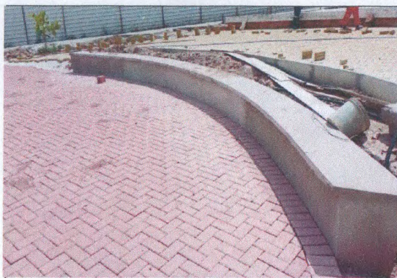
PAVIMENTAÇÃO EM INTERTRAVADO
