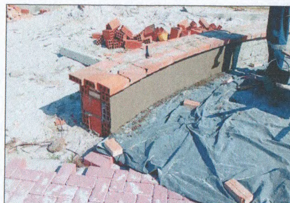
BANCOS DE CONCRETO
