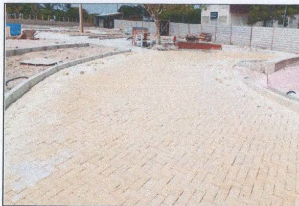
PAVIMENTAÇÃO EM INTERTRAVADO
