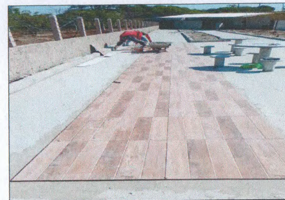
EXECUÇÃO DO PISO CERÂMICO
