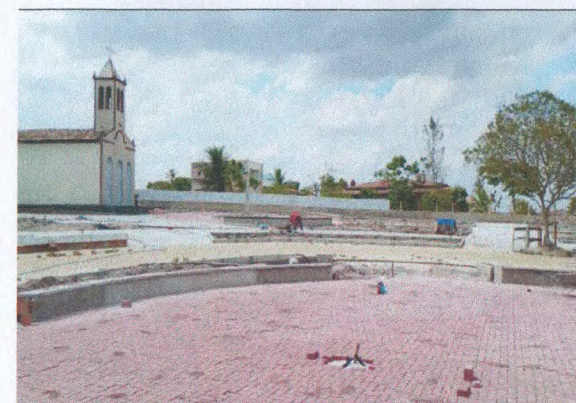
PAVIMENTAÇÃO EM INTERTRAVADO
