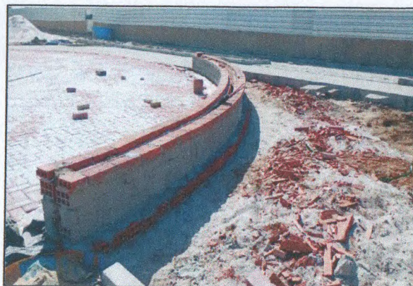
BANCOS DE CONCRETO
