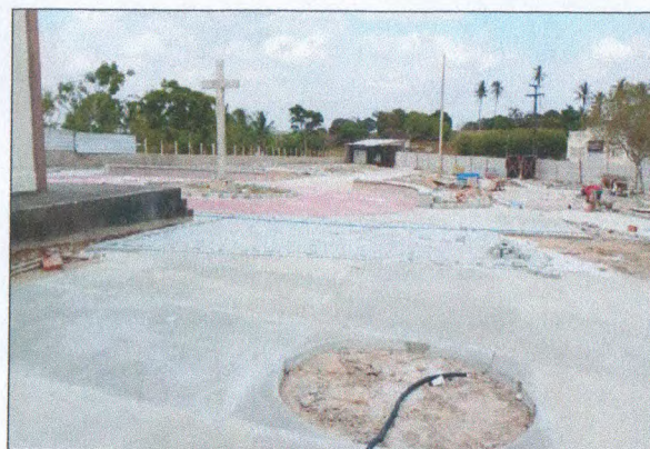
PISO EM CONCRETO
