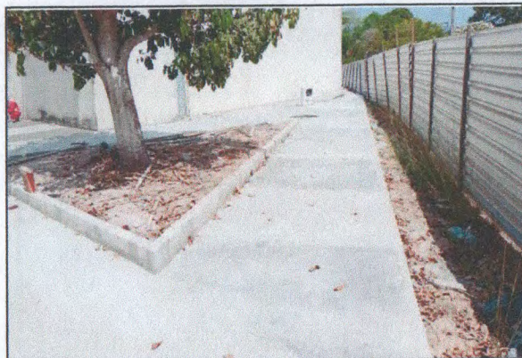
PISO EM CONCRETO
