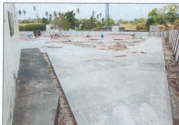
PISO EM CONCRETO
