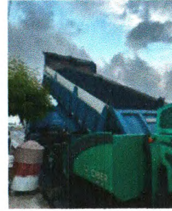
RECAPEAMENTO ASFÁLTICO
