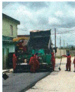
RECAPEAMENTO ASFÁLTICO
