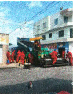
RECAPEAMENTO ASFÁLTICO
