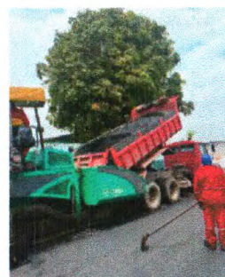
RECAPEAMENTO ASFÁLTICO
