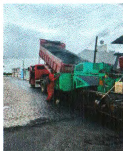
RECAPEAMENTO ASFÁLTICO
