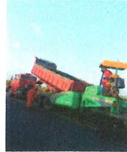
RECAPEAMENTO ASFÁLTICO
