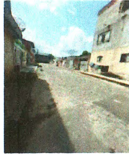
RECAPEAMENTO ASFÁLTICO TRAVESSA 05 - RUA SÃO LUIZ
