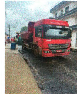
RECAPEAMENTO ASFÁLTICO
