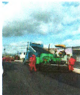
RECAPEAMENTO ASFÁLTICO
