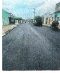
RECAPEAMENTO ASFÁLTICO
