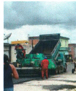
RECAPEAMENTO ASFÁLTICO
