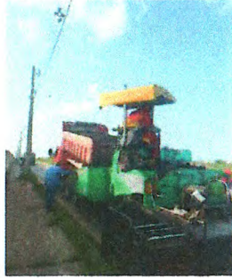
RECAPEAMENTO ASFÁLTICO
