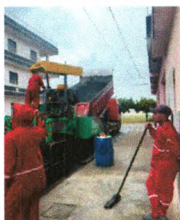
RECAPEAMENTO ASFÁLTICO
