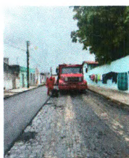
RECAPEAMENTO ASFÁLTICO
