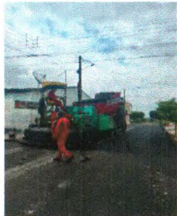
RECAPEAMENTO ASFÁLTICO
