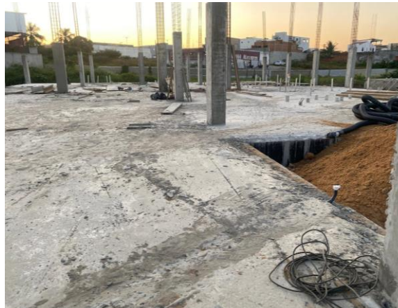
CAMADA IMPERMEABILIZADORA, INSTALAÇÕES HIDRAULICAS E INSTALAÇÕES ELÉTRICAS
