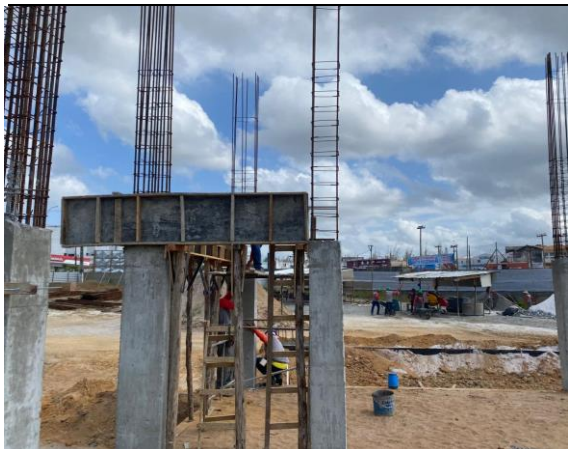
FORMA DAS VIGAS, CORTE E DOBRA DE AÇO PARA AS VIGAS, CONCRETAGEM DOS PILARES E VIGAS
