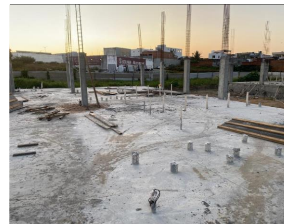
CAMADA IMPERMEABILIZADORA E INSTALAÇÕES SANITÁRIAS E INSTALAÇÕES ELÉTRICAS
