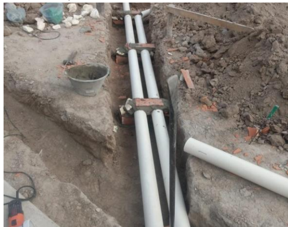
DRENAGEM PLUVIAL
