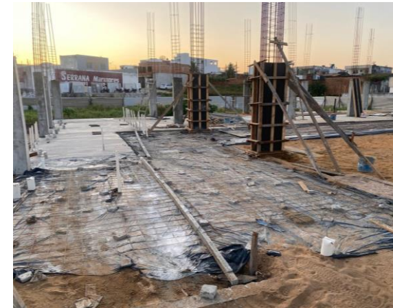
CAMADA IMPERMEABILIZADORA, FORMA E CONCRETAGEM DOS PILARES
