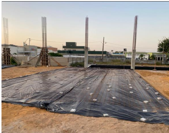
PREPARO PARA A CAMADA IMPERMEABILIZADORA E CONCRETAGEM DOS PILARES
