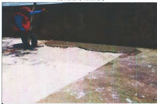
EXECUÇÃO DE PASSEIO
