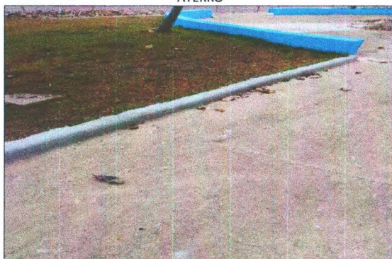
ASSENTAMENTO DE MEIO FIO
