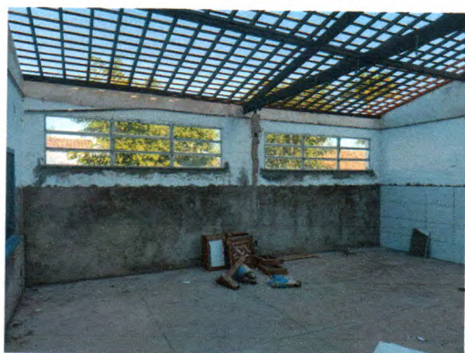
Fotos 02. Remoção de revestimento interno, chapisco, reboco e apicotamento. Remoção de telhado para lavagem das telhas. Troca de madeiramento danificado
