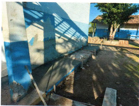
Fotos 01. Execução de reboco externo e passeio do Bloco das Salas de Aulas
