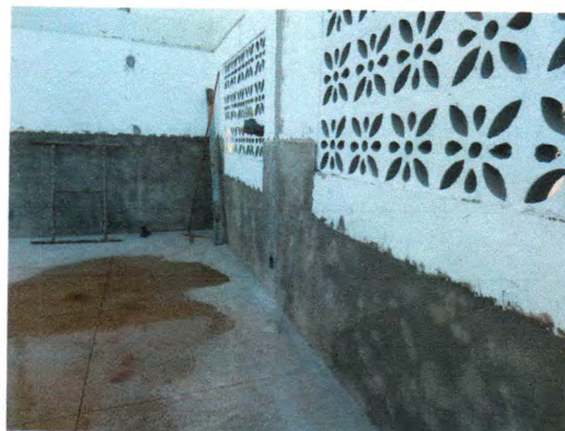
Fotos 02. Remoção de revestimento interno, chapisco, reboco e apicotamento. Remoção de telhado para lavagem das telhas. Troca de madeiramento danificado
