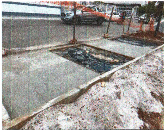
LONA PLÁSTICA E PISO EM CONCRETO
