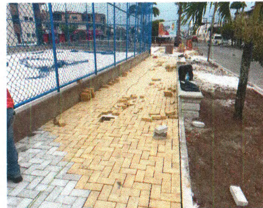
INTERTRAVADO, CAIXA PRÉ MOLDADA E HASTE TERRA
