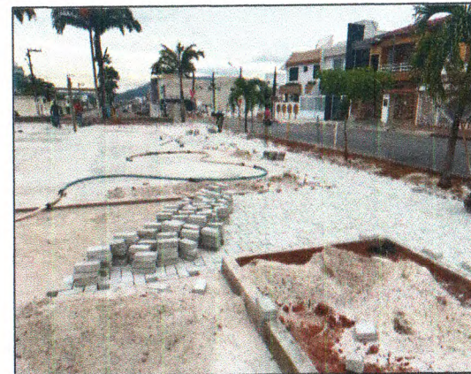
PISO EM CONCRETO E INTERTRAVADO
