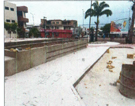
PISO EM CONCRETO, REBOCO, ATERRO E INTERTRAVADO
