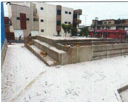
PISO EM CONCRETO, REBOCO, ATERRO E INTERTRAVADO
