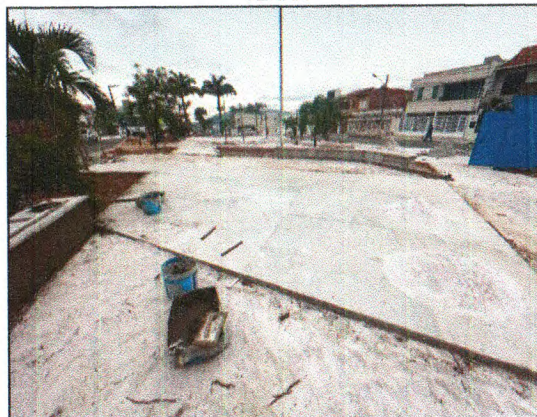
PISO EM CONCRETO
