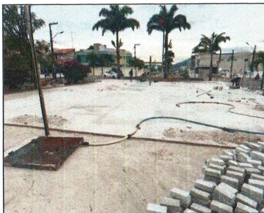
PISO EM CONCRETO
