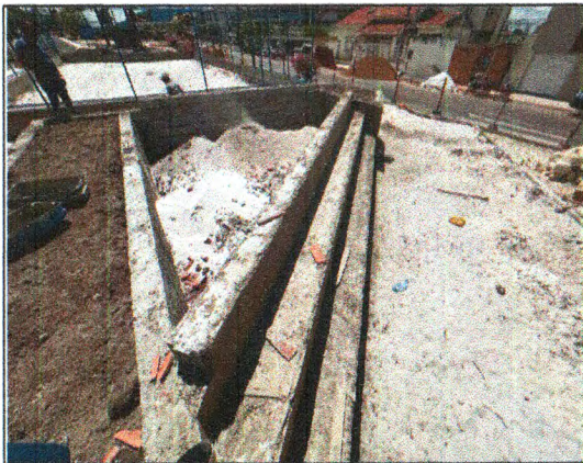
PISO EM CONCRETO, REBOCO, ATERRO E INTERTRAVADO
