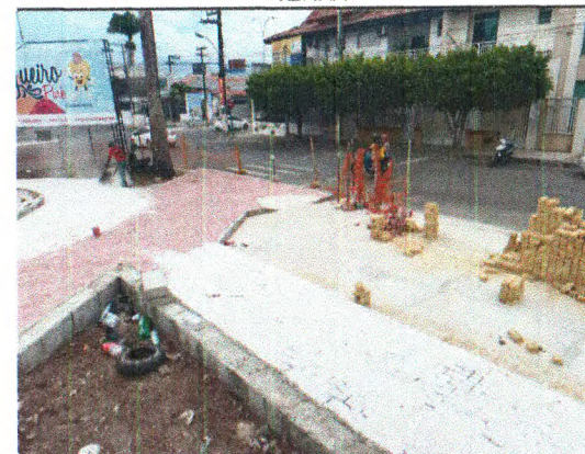
PISO EM CONCRETO E INTERTRAVADO
