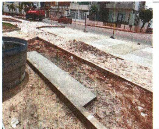
PISO EM CONCRETO
