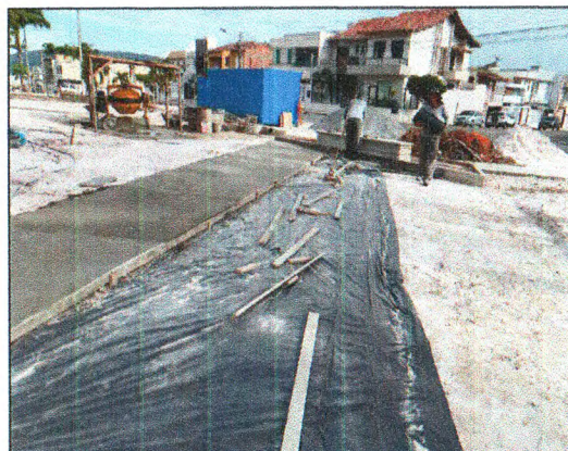
LONA PLÁSTICA E PISO EM CONCRETO
