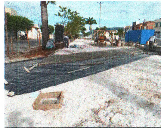
LONA PLÁSTICA E PISO EM CONCRETO
