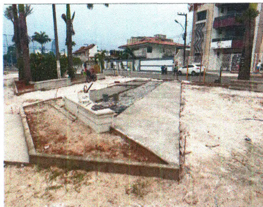
LONA PLÁSTICA E PISO EM CONCRETO
