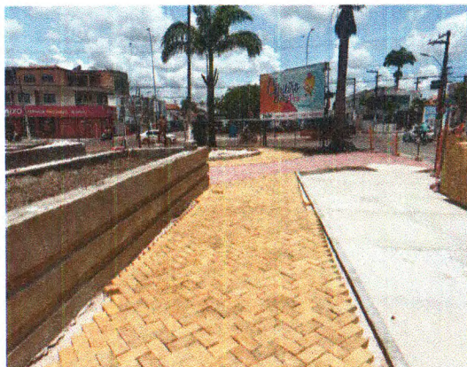
PISO EM CONCRETO E INTERTRAVADO
