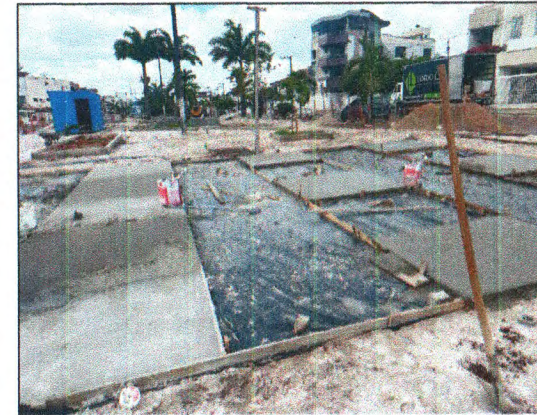
LONA PLÁSTICA E PISO EM CONCRETO
