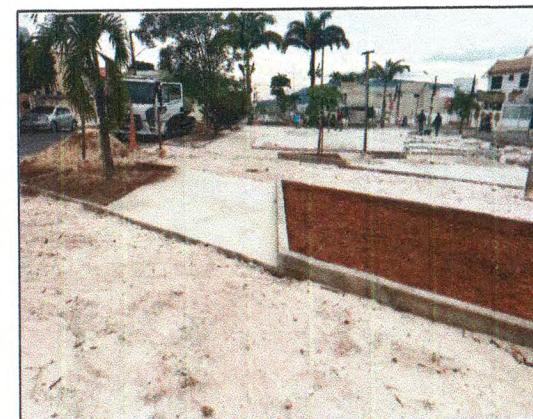
PISO EM CONCRETO
