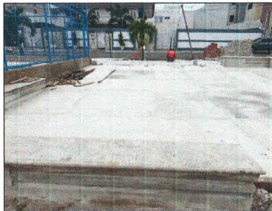
PISO EM CONCRETO
