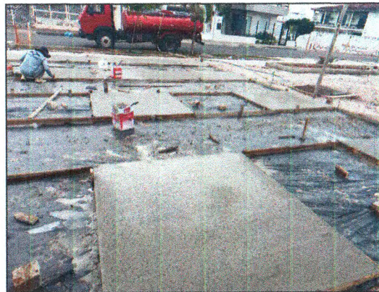
LONA PLÁSTICA E PISO EM CONCRETO
