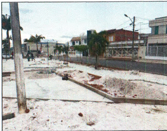
PISO EM CONCRETO, CAIXA PRÉ MOLDADA E HASTE TERRA
