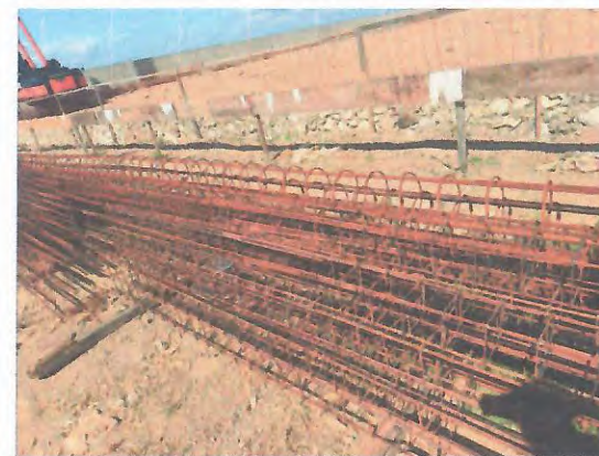
CORTE - DOBRAGEM DE AÇO - MURO
