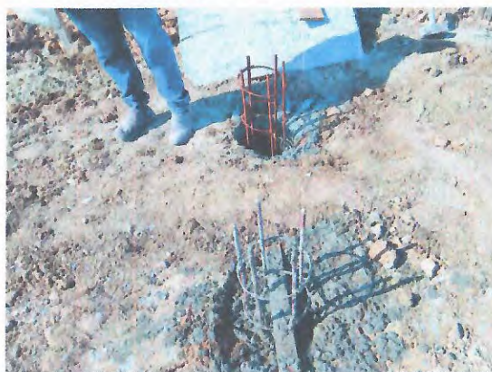
EXECUÇÃO DE FUNDAÇÕES
