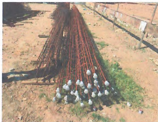
CORTE - DOBRAGEM DE AÇO
