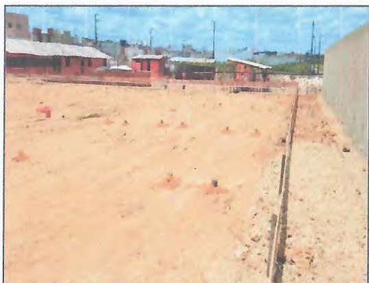
LOCAÇÃO DAS ESTACAS - EXECUÇÃO MURO EM BLOCO CERÂMICO
