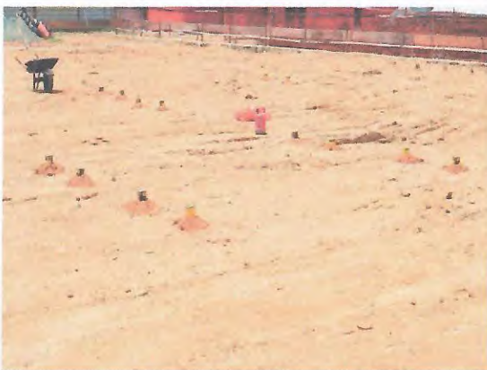
LOCAÇÃO DAS ESTACAS
