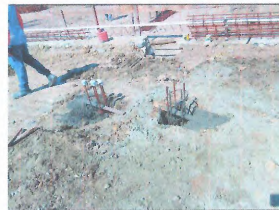
EXECUÇÃO DE FUNDAÇÕES
