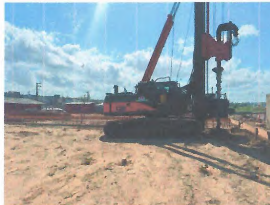
EXECUÇÃO DE FUNDAÇÕES
