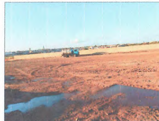
SERVIÇOS DE TERRAPLANAGEM - EXECUÇÃO MURO EM BLOCO CERÂMICO
