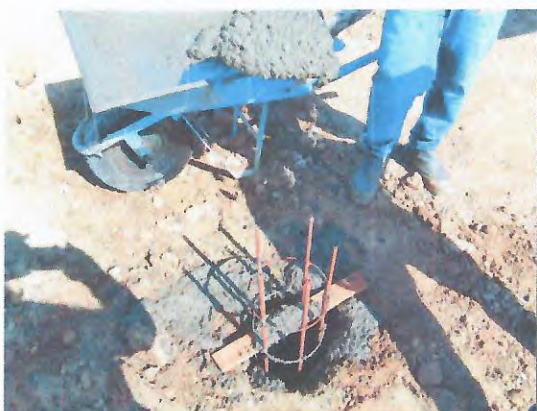
EXECUÇÃO DE FUNDAÇÕES
