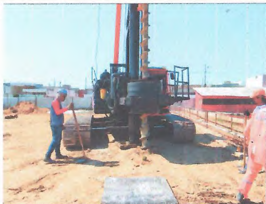
EXECUÇÃO DE FUNDAÇÕES
