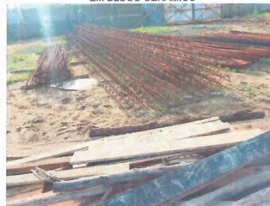
CORTE - DOBRAGEM DE AÇO
