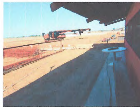
EXECUÇÃO DE FUNDAÇÕES
