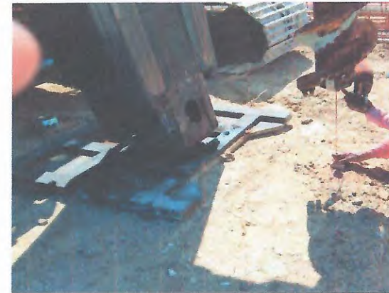
EXECUÇÃO DE FUNDAÇÕES
