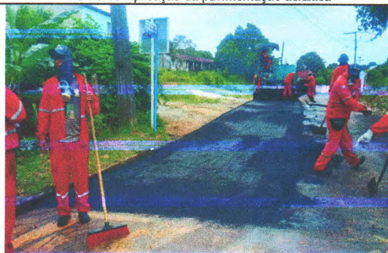
FOTO 12-Aplicação da pavimentação asfáltica
