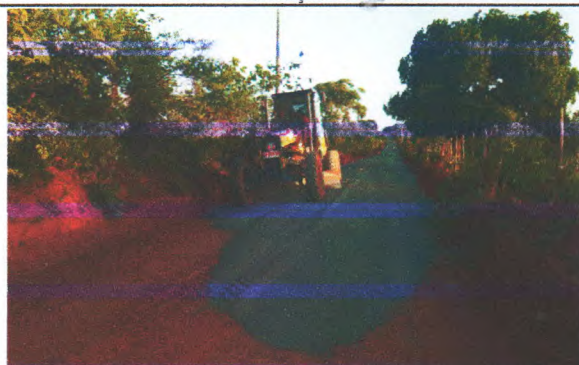
FOTO 04- Execução da imprimação
