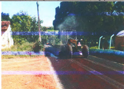
FOTO 07- Execução de pintura asfáltica de ligação
