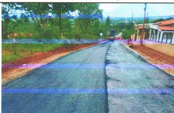
FOTO 14-Aplicação da pavimentação asfáltica
