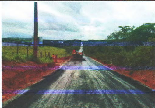
FOTO 07- Execução de pintura asfáltica de ligação
