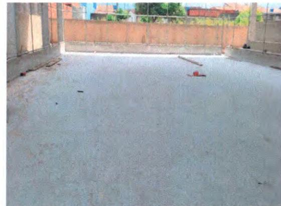
CAMADA IMPERMEABILIZADORA DE CONCRETO
