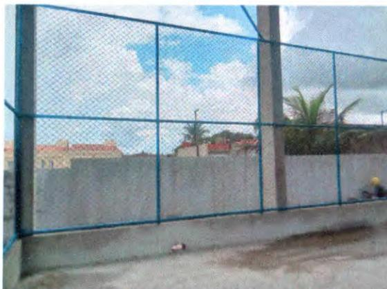
ALAMBRADO EM TUBO GALVANIZADO COM TELA REVESTIDA EM PVC
