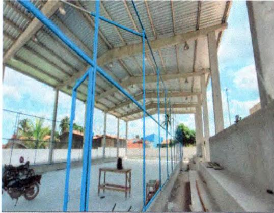
ALAMBRADO EM TUBO GALVANIZADO
