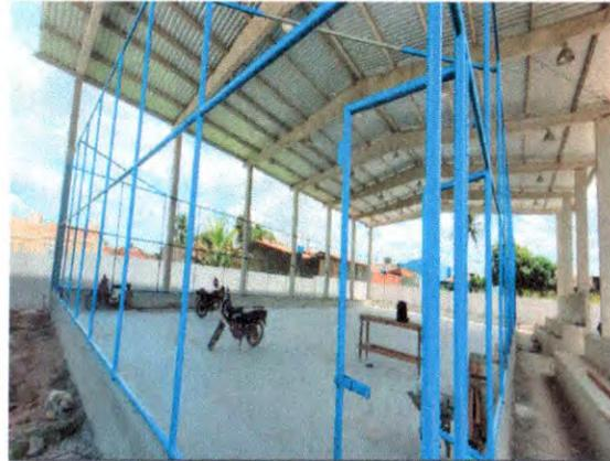
ALAMBRADO EM TUBO GALVANIZADO
