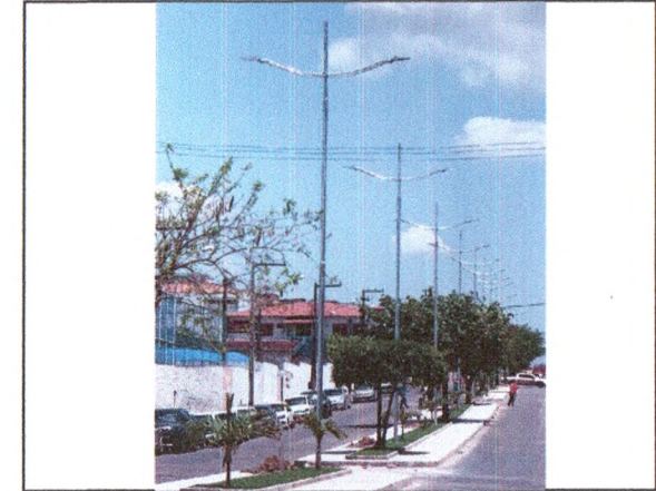
POSTES E LUMINÁRIAS
