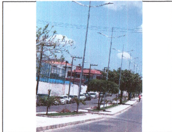
POSTES E LUMINÁRIAS
