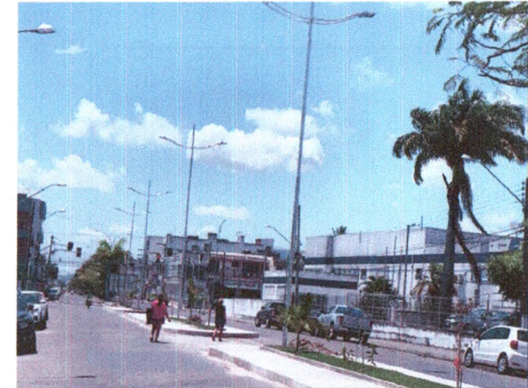
POSTES E LUMINÁRIAS
