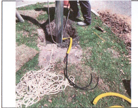
IMPLANTAÇÃO DE POSTES E LUMINÁRIAS; INSTALAÇÕES ELÉTRICAS
