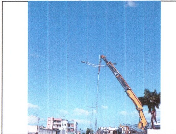
IMPLANTAÇÃO DE POSTES E LUMINÁRIAS
