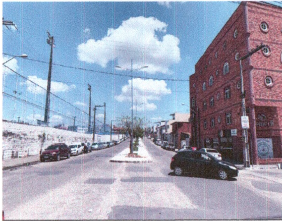
POSTES E LUMINÁRIAS
