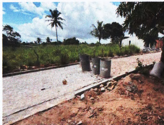
MEIO FIO, COLCHÃO DE AREIA E PARALELEPÍPEDO
