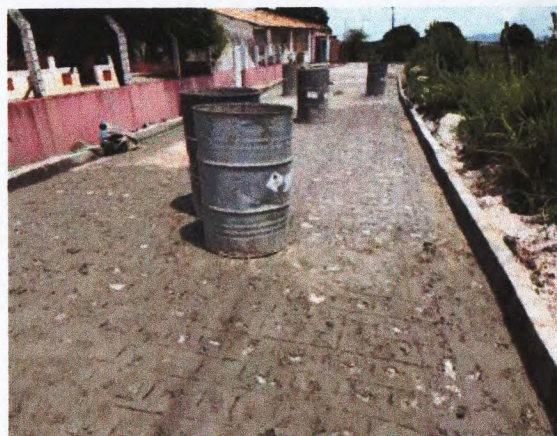
PAVIMENTAÇÃO E REJUNTAMENTO
