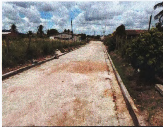
PAVIMENTAÇÃO REJUNTADA E MEIO FIO
