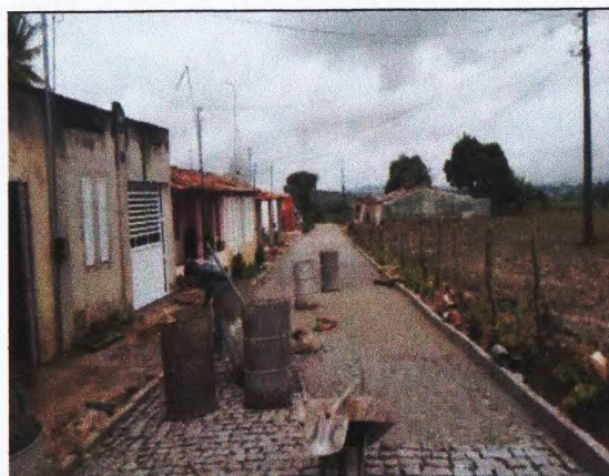
MEIO FIO, PARALELEPÍPEDO E REJUNTE
