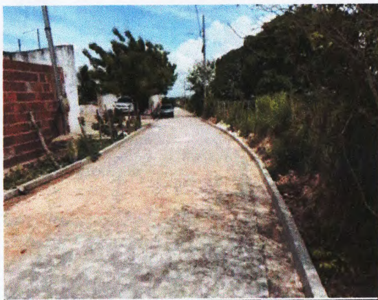
PAVIMENTAÇÃO REJUNTADA E MEIO FIO
