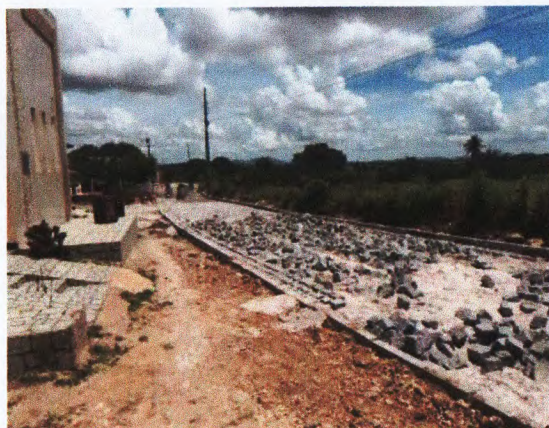
MEIO FIO, COLHÃO DE AREIA E PARALELEPÍPEDO
