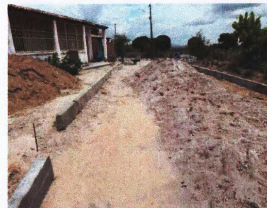
MEIO FIO E COLCHÃO DE AREIA
