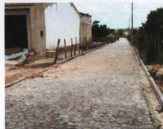
PAVIMENTAÇÃO E REJUNTAMENTO
