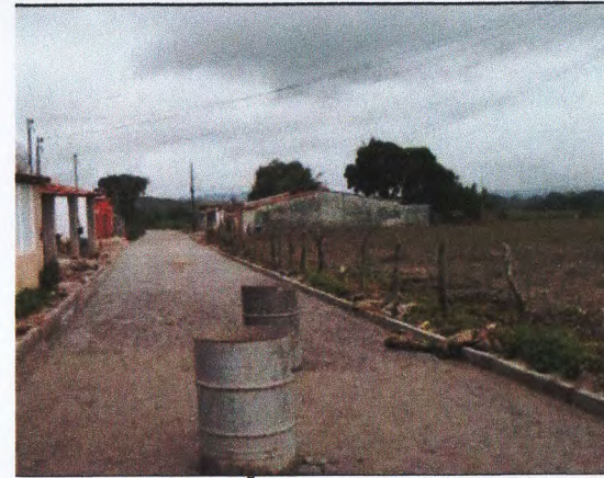
PAVIMENTAÇÃO REJUNTADA E MEIO FIO
