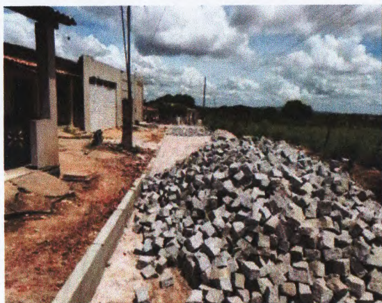
MEIO FIO, COLHÃO DE AREIA E PARALELEPÍPEDO
