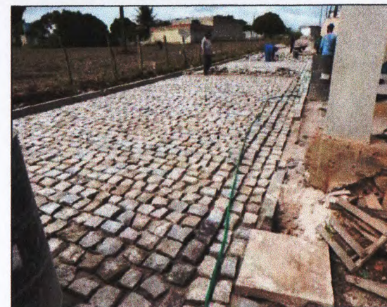
MEIO FIO E PARALELEPÍPEDO
