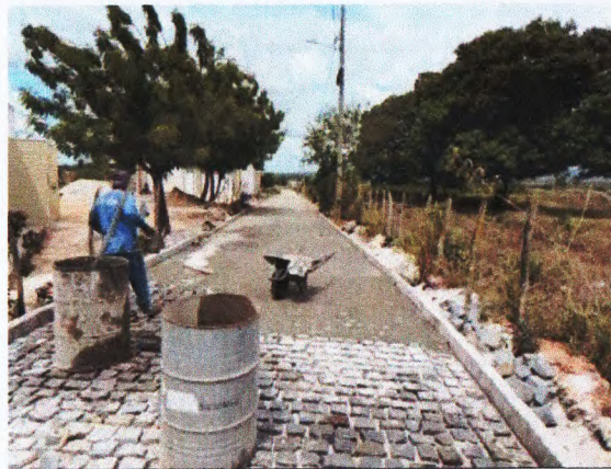
MEIO FIO, PARALELEPÍPEDO E REJUNTE
