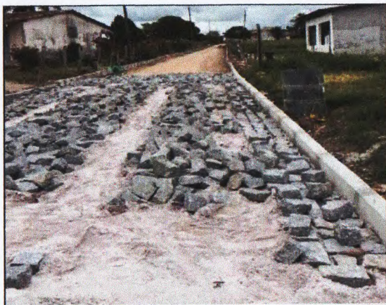
MEIO FIO, COLCHÃO DE AREIA E PARALELEPÍPEDO
