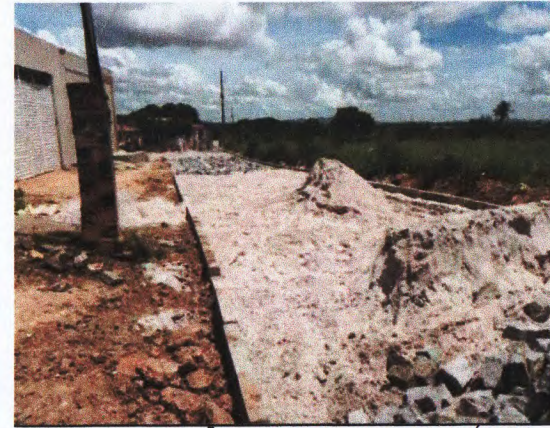
MEIO FIO, COLHÃO DE AREIA E PARALELEPÍPEDO
