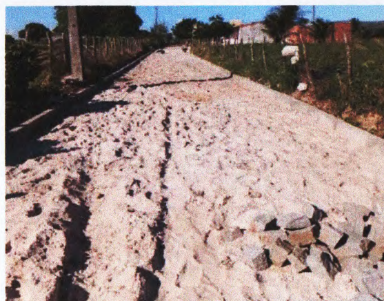
MEIO FIO E COLCHÃO DE AREIA
