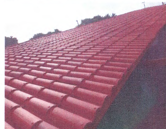
REVISÃO DA COBERTURA; RETELHAMENTO COM TELHAS NOVAS
