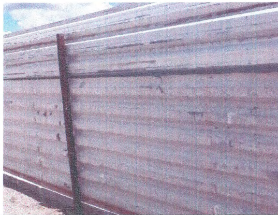
TAPUME EM CHAPA DE AÇO GALVANIZADA
