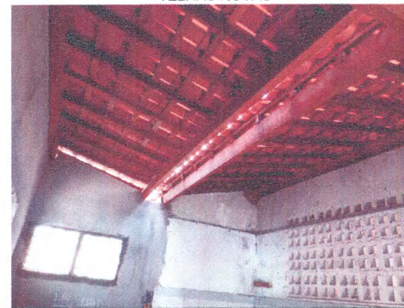
AMPLIAÇÃO - ALVENARIA DE BLOCO; CHAPISCO; REBOCO; COMBOGÓ; MADEIRAMENTO E TELHAS CERÂMICA
