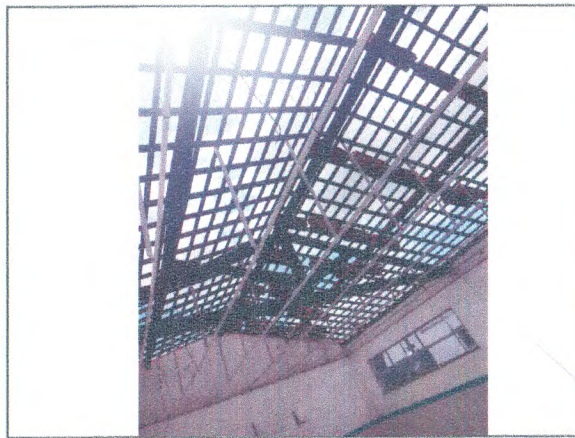
REVISÃO DA COBERTURA EM TELHA CERÂMICA
