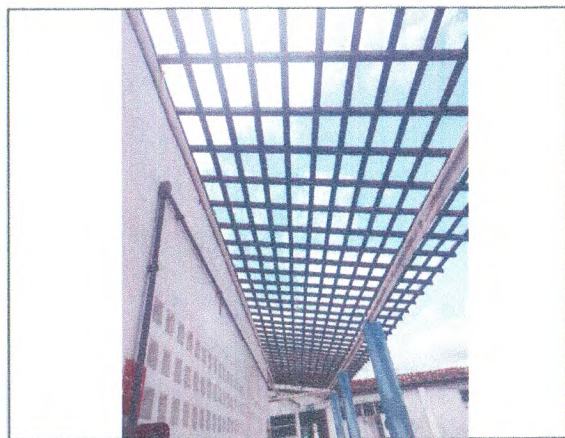
REVISÃO DA COBERTURA EM TELHA CERÂMICA
