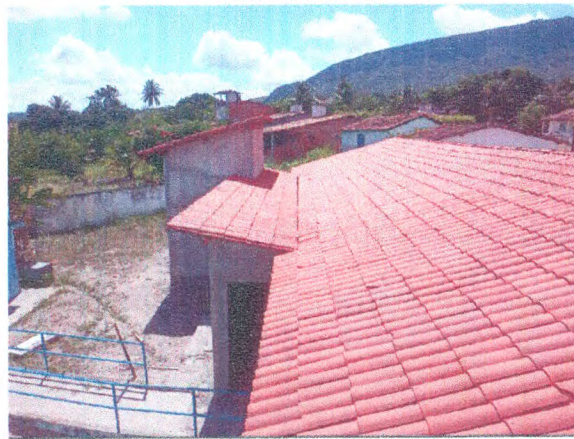
AMPLIAÇÃO - ALVENARIA DE BLOCO; CHAPISCO; REBOCO; COBERTURA COM TELHAS CERÂMICA
