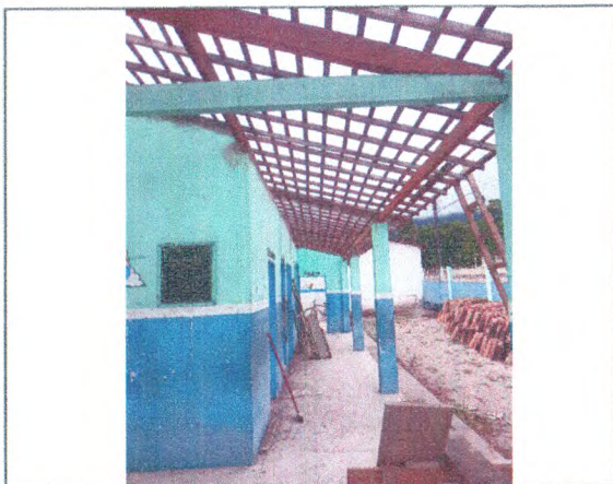
REVISÃO DA COBERTURA EM TELHA CERÂMICA; SUBSTITUIÇÃO DE PEÇAS EM MADEIRA
