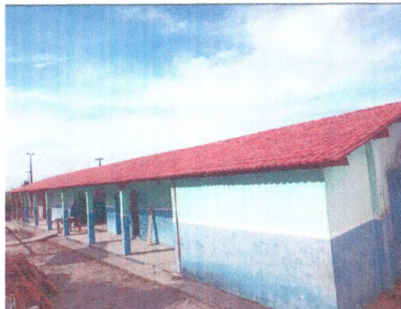
REVISÃO DA COBERTURA; RETELHAMENTO COM TELHAS NOVAS
