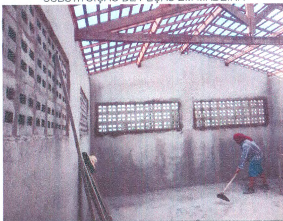
AMPLIAÇÃO - ALVENARIA DE BLOCO; CHAPISCO; REBOCO; COMBOGÓ; MADEIRAMENTO E REGULARIZAÇÃO DO PISO
