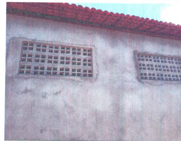
AMPLIAÇÃO - ALVENARIA DE BLOCO; CHAPISCO; REBOCO; COMBOGÓ; COBERTURA TELHA CERÂMICA
