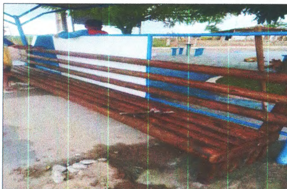
ASSENTAMENTO DE EUCALIPTO
