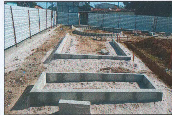
MEIO FIO CANTEIRO 05 E 06
