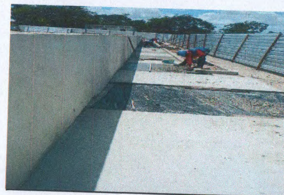
MEIO FIO CANTEIRO 11
