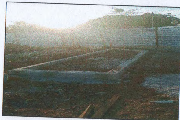
MEIO FIO CANTEIRO 10
