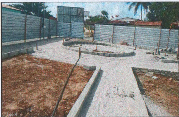
MEIO FIO CANTEIRO 04
