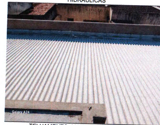
TELHAMENTO, MANTA, CALHA E RUFO
