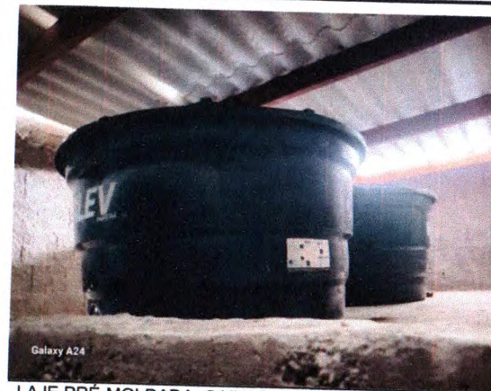
LAJE PRÉ-MOLDADA, CAIXAS D'ÁGUA E INSTALAÇÕES HIDRAULICAS
