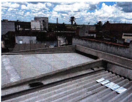
PRIME, MANTA, CALHA, RUFO E TELHAMENTO
