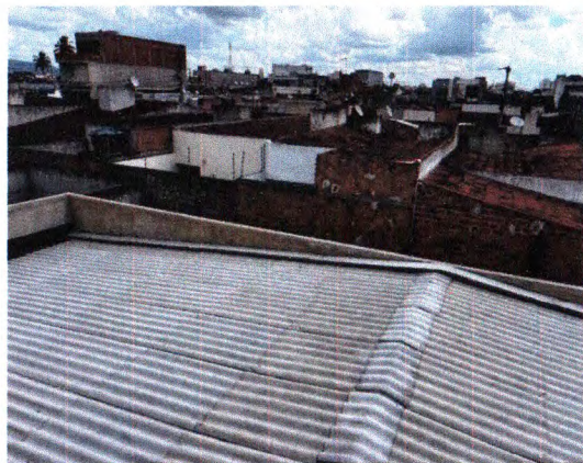
PRIME, MANTA, CALHA, RUFO E TELHAMENTO
