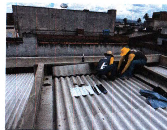
PRIME, MANTA, CALHA, RUFO E TELHAMENTO
