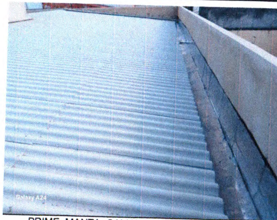
PRIME, MANTA, CALHA, RUFO E TELHAMENTO
