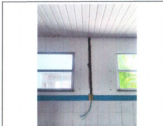
INSTALAÇÃO ELÉTRICA; INSTALAÇÃO DO FORRO DE PVC
