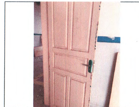
REVISÃO DE ESQUADRIA DE MADEIRA; SUBSTITUIÇÃO DE FECHADURA; PINTURA INTERNA DE PAREDE
