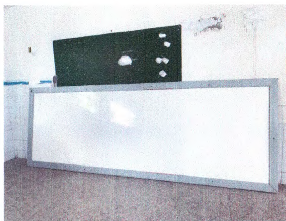
INSTALAÇÃO ELÉTRICA; INSTALAÇÃO DE QUADRO DE FÓRMICA BRANCA
