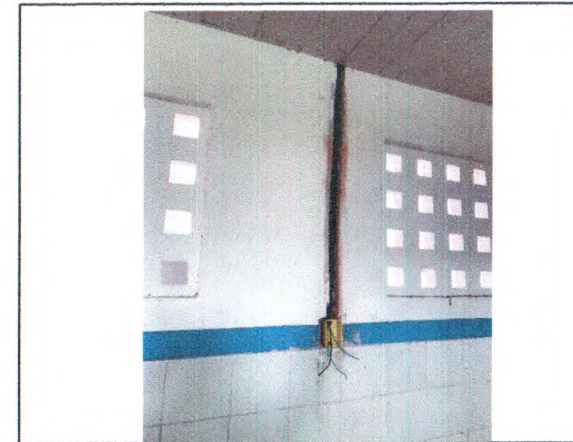
INSTALAÇÃO ELÉTRICA; INSTALAÇÃO DO FORRO DE PVC
