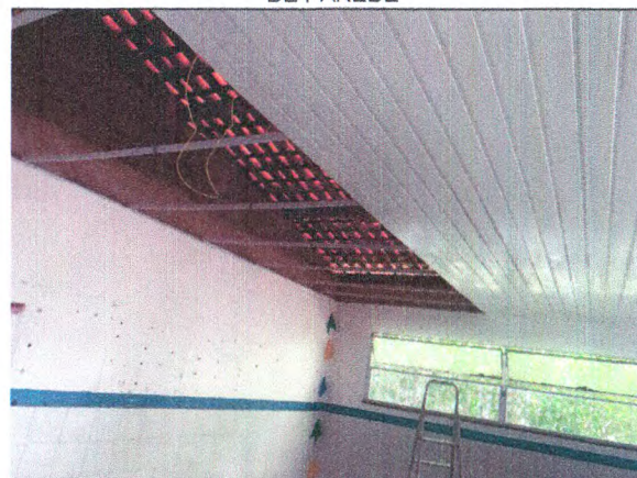
INSTALAÇÃO ELÉTRICA; INSTALAÇÃO DO FORRO DE PVC
