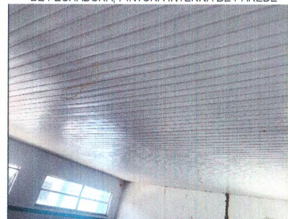
INSTALAÇÃO ELÉTRICA; INSTALAÇÃO DO FORRO DE PVC
