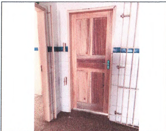
PORTA DE MADEIRA ALMOFADADA; PINTURA INTERNA DE PAREDE
