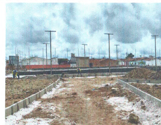
MEIO FIO; ALVENARIA DA QUADRA; REFLETORES
