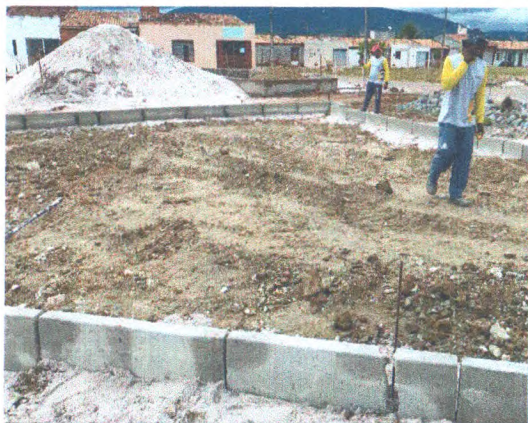
ASSENTAMENTO DE MEIO FIO;
