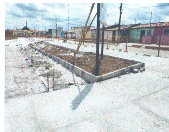
ASSENTAMENTO DE MEIO FIO; PISO EM CONCRETO
