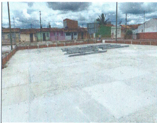
ALVENARIA DE BLOCO CERÂMICO; QUADROS DO ALAMBRADO
