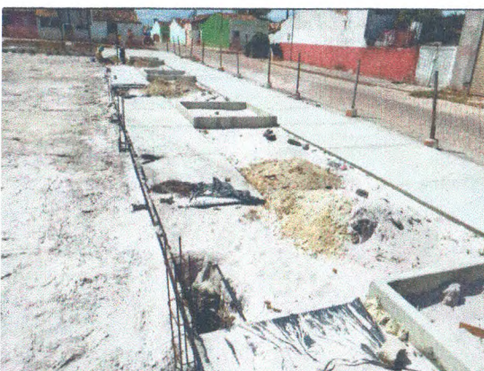
PISO EM CONCRETO;
