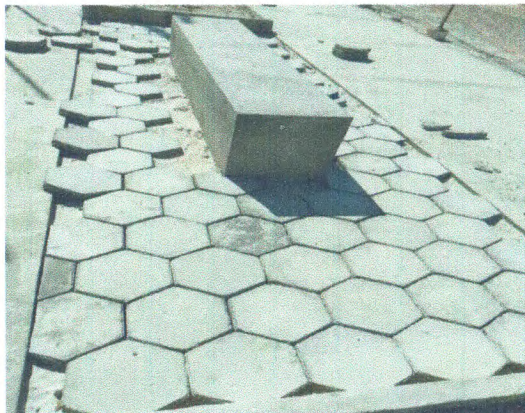
BANCO EM CONCRETO E PISO INTERTRAVADO
