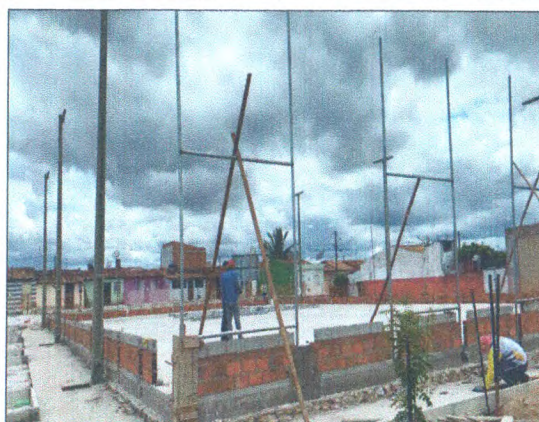
ALVENARIA DE BLOCO CERÂMICO; QUADROS DO ALAMBRADO
