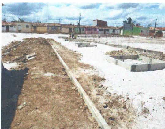
ASSENTAMENTO DE MEIO FIO
