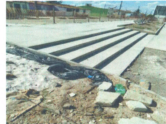
ESCADARIA EM CONCRETO SIMPLES
