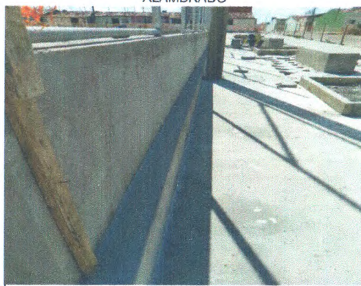
REBOCO; PASSEIO; BANCO DE CONCRETO
