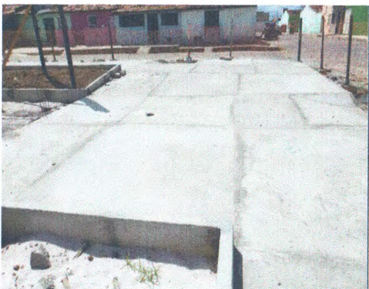
PISO EM CONCRETO;
