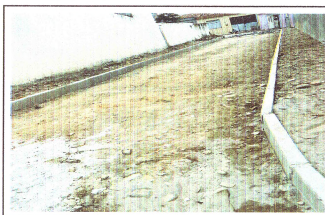
PAVIMENTAÇÃO DA TRAVESSA JOSÉ PEREIRA
