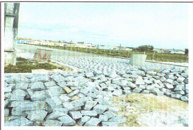
PAVIMENTAÇÃO NA TRAVESSA MURINO JOSÉ DA SILVA
