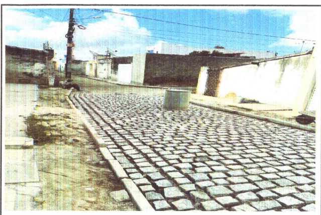
PAVIMENTAÇÃO DA TRAVESSA JOSÉ PEREIRA
