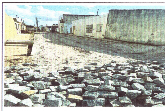
PAVIMENTAÇÃO DA TRAVESSA JOSÉ PEREIRA
