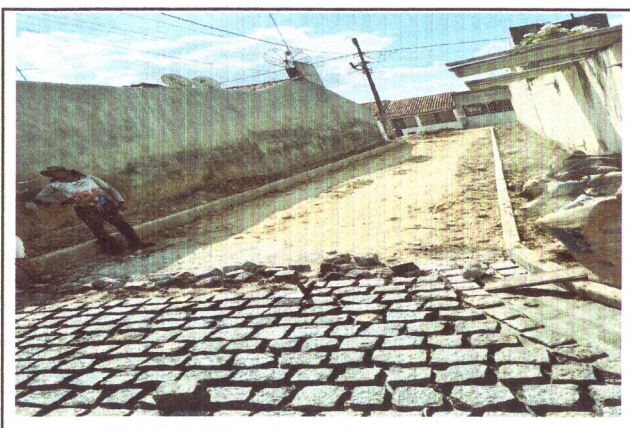
PAVIMENTAÇÃO DA TRAVESSA JOSÉ PEREIRA
