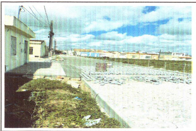
PAVIMENTAÇÃO NA TRAVESSA MURINO JOSÉ DA SILVA
