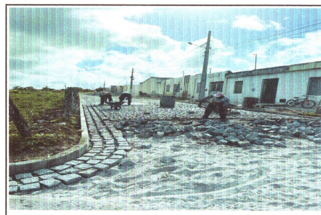
PAVIMENTAÇÃO NA TRAVESSA MURINO JOSÉ DA SILVA
