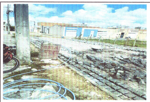
PAVIMENTAÇÃO NA TRAVESSA MURINO JOSÉ DA SILVA
