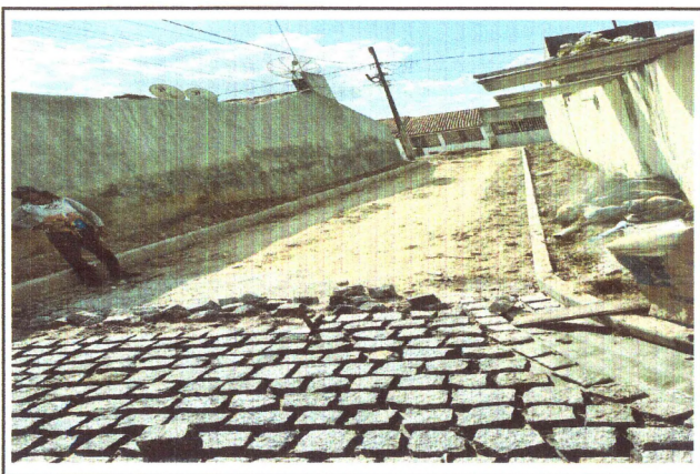
PAVIMENTAÇÃO DA TRAVESSA JOSÉ PEREIRA
