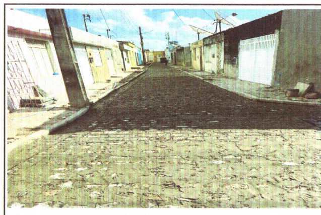
PAVIMENTAÇÃO DA TRAVESSA JOSÉ PEREIRA
