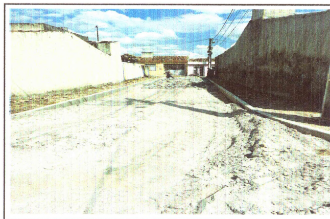
PAVIMENTAÇÃO DA TRAVESSA JOSÉ PEREIRA
