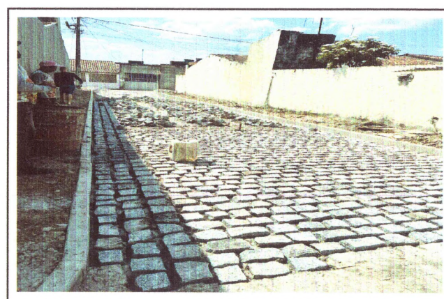
PAVIMENTAÇÃO DA TRAVESSA JOSÉ PEREIRA
