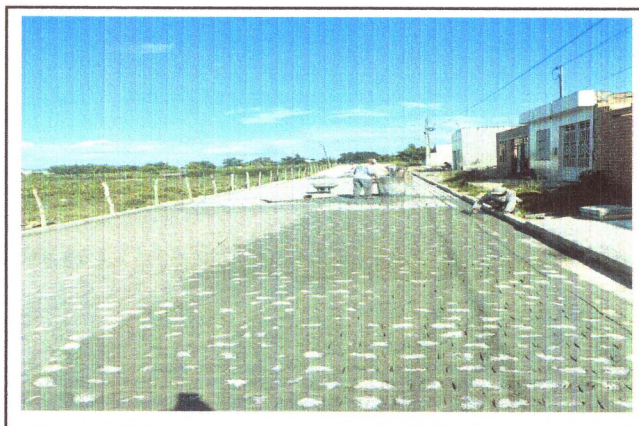
PAVIMENTAÇÃO NA TRAVESSA MURINO JOSÉ DA SILVA
