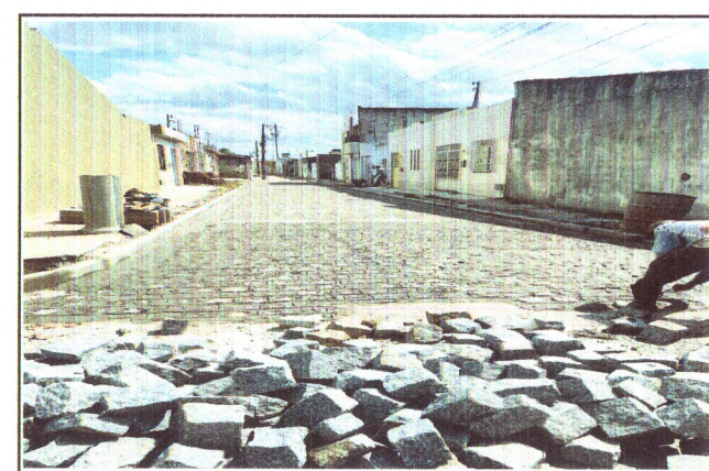
PAVIMENTAÇÃO DA TRAVESSA JOSÉ PEREIRA
