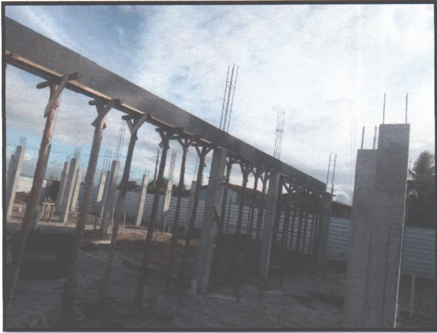
Figura 32: Montagem de forma para concretagem de viga
