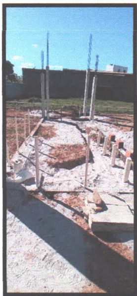
Figura 16: Aterro de vala de Instalações hidrossanitária
