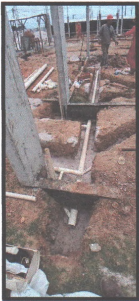
Figura 8: Instalações hidrossanitária
