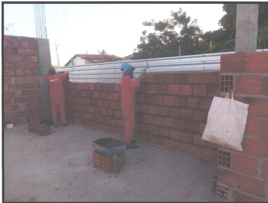
Figura 39: Execução de alvenaria
