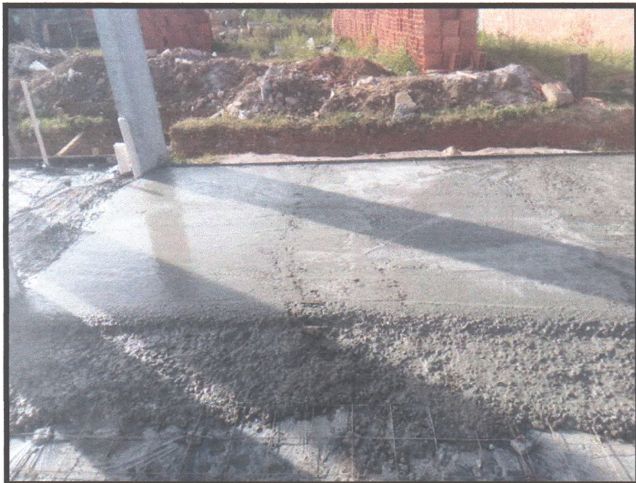
Figura 33: Concretagem de piso
