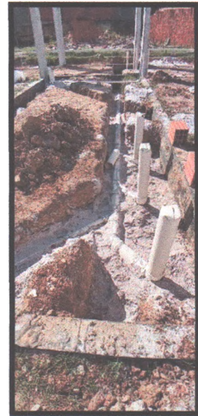
Figura 10: Instalações hidrossanitária
