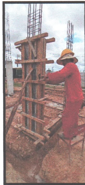
Figura 3: Montagem de forma de pilares
