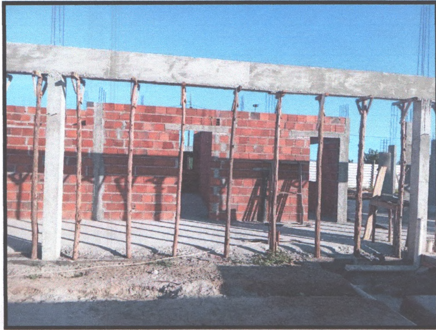
Figura 42: Execução de alvenaria
