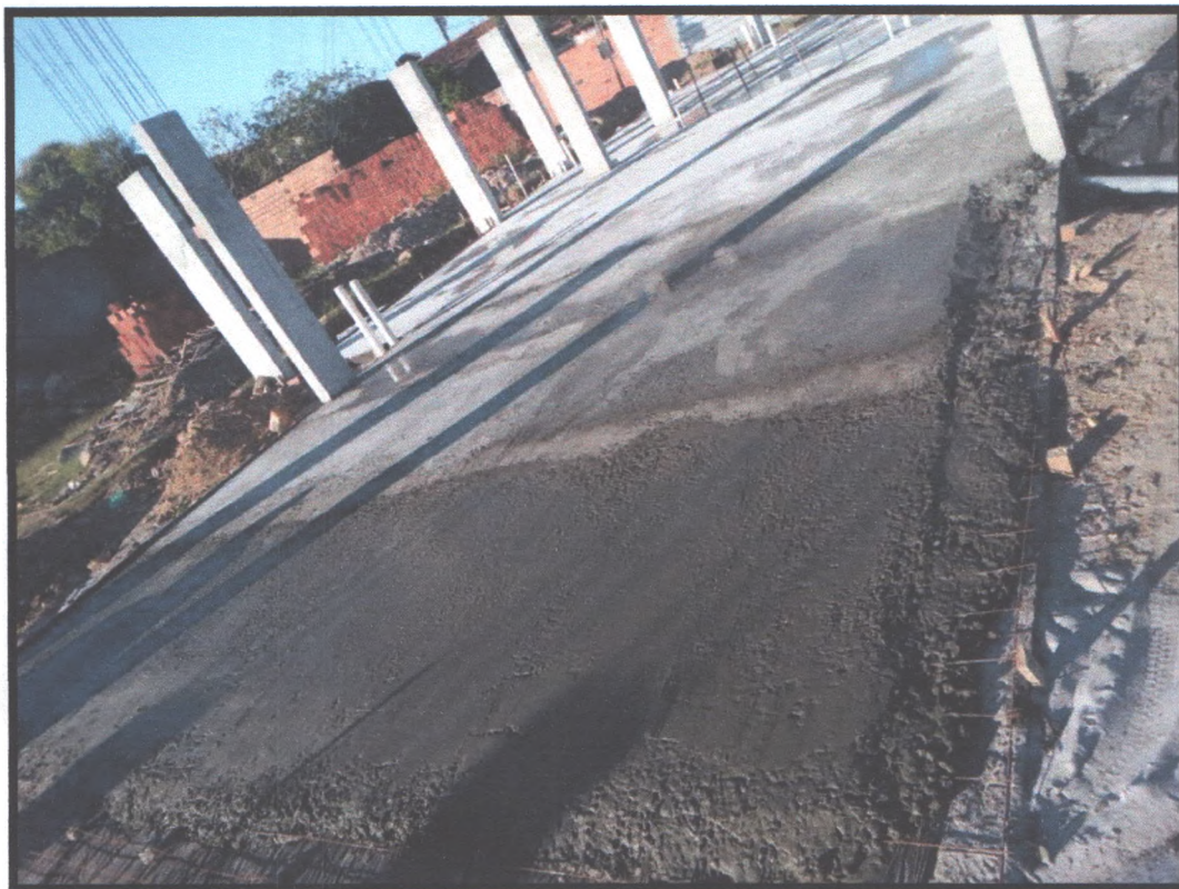
Figura 34: Concretagem de piso
