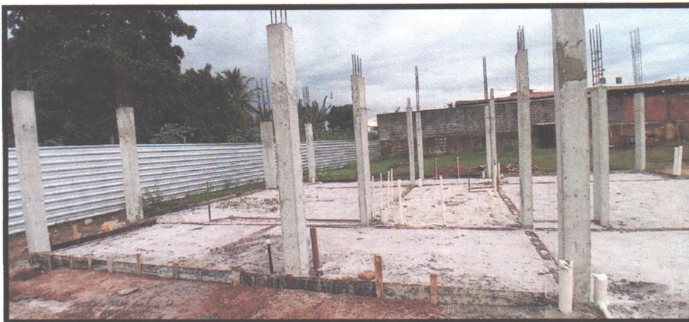
Figura 26: Colchão de areia
