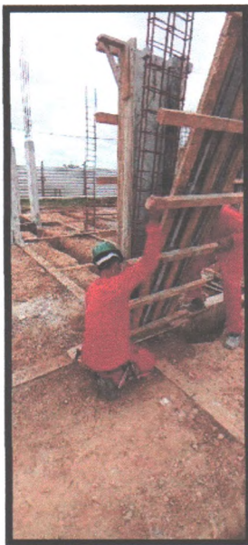
Figura 2: Montagem de forma de pilares
