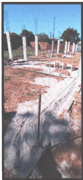
Figura 17: Aterro de vala de Instalações hidrossanitária
