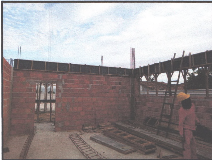
Figura 41: Execução de alvenaria de vedação e montagem de forma para concretagem de viga
