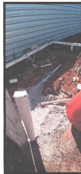
Figura 18: Aterro de vala de Instalações hidrossanitária
