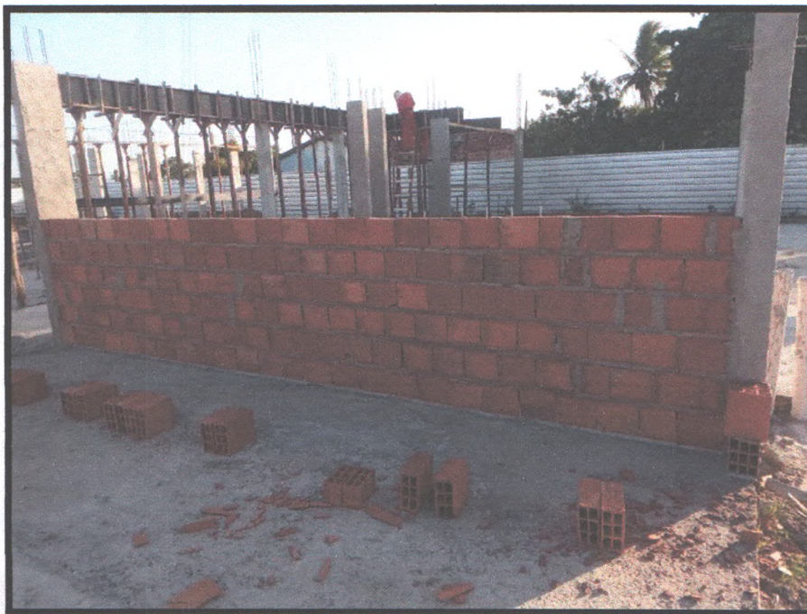
Figura 36: Execução de alvenaria de vedação e montagem de forma para concretagem de viga
