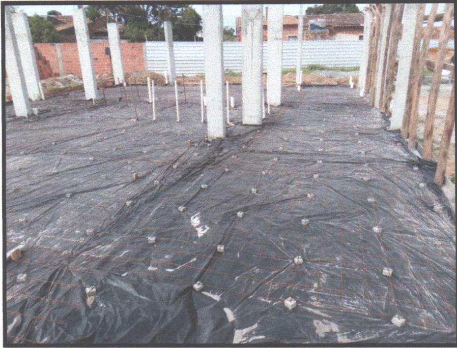
Figura 30: Lona plástica e tela de aço para concretagem de piso armado
