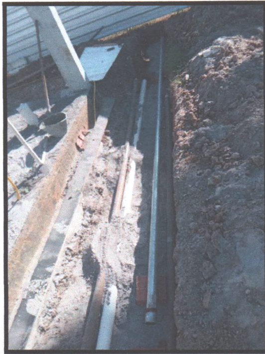
Figura 28: Instalações enterradas
