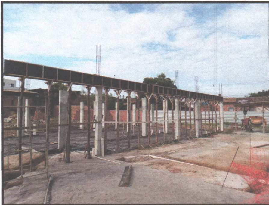
Figura 31: Montagem de forma para concretagem de viga
