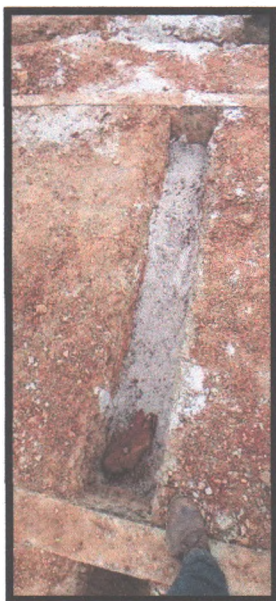
Figura 4: Colchão de areia
