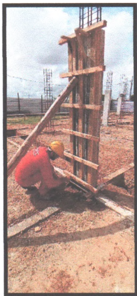
Figura 1: Montagem de forma de pilares
