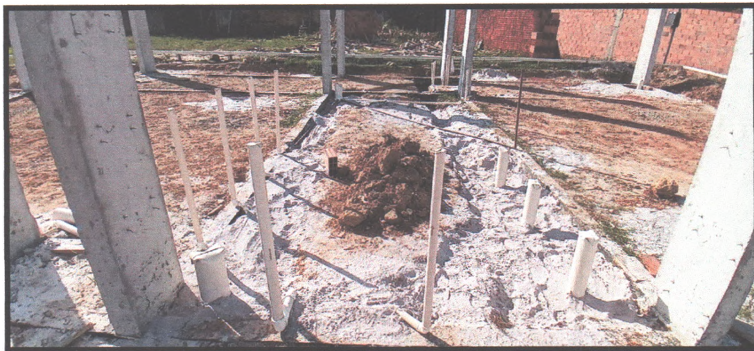
Figura 15: Aterro de vala de Instalações hidrossanitária
