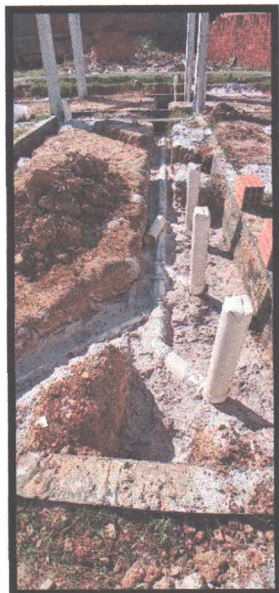
Figura 11: Instalações hidrossanitária
