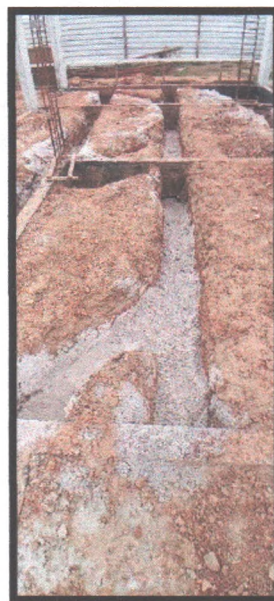
Figura 6: Colchão de areia
