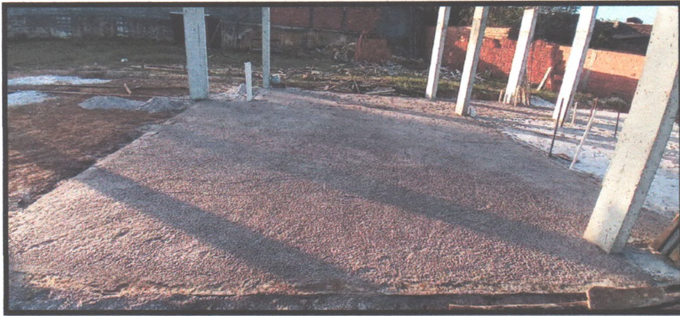
Figura 23: Aterro de instalações hidrossanitária
