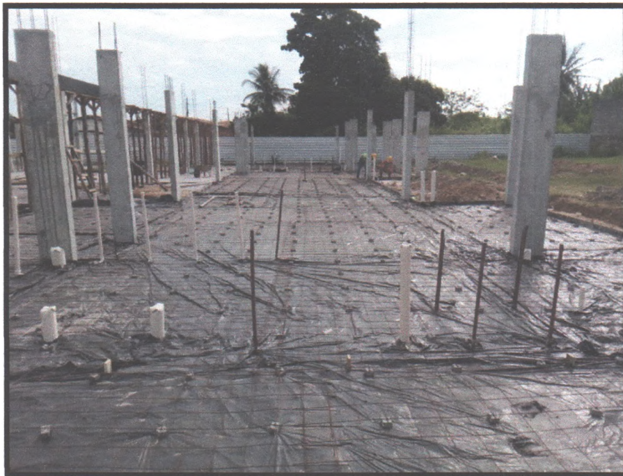
Figura 29: Lona plástica e tela de aço para concretagem de piso armado
