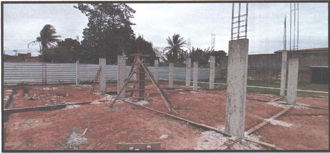
Figura 7: Concretagem de pilares
