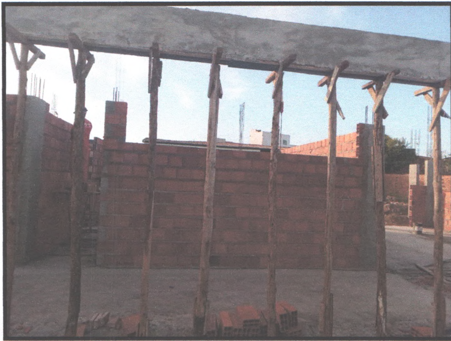
Figura 38: Execução de alvenaria
