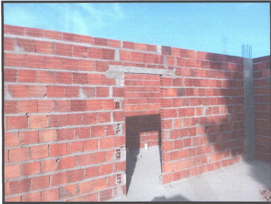
Figura 40: Execução de alvenaria
