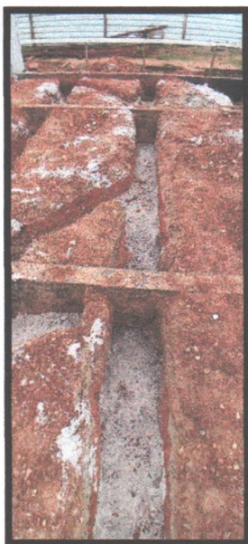
Figura 5: Colchão de areia
