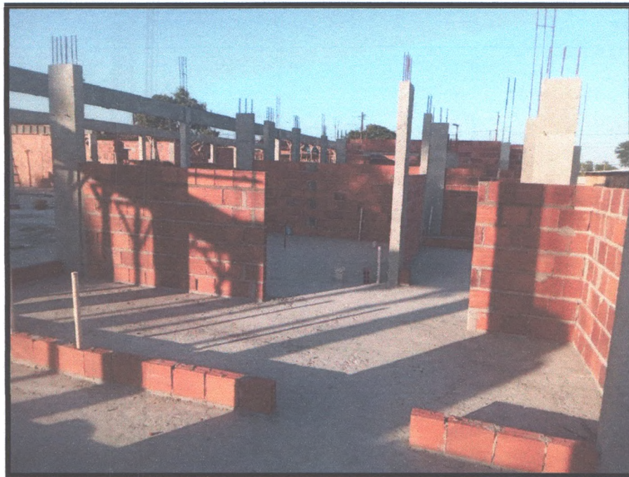
Figura 43: Execução de alvenaria
