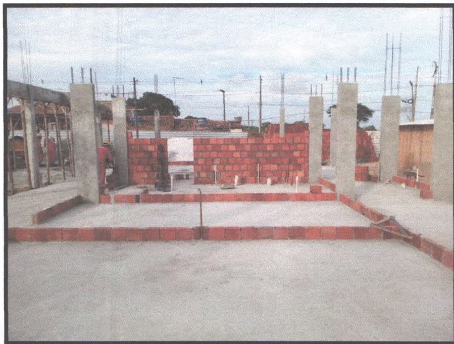
Figura 44: Execução de alvenaria de vedação
